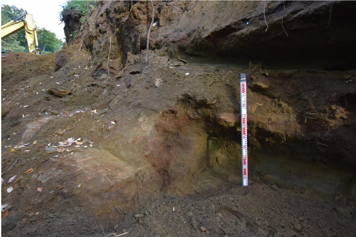
Figuur 10. Wand 2, observatiepunt 3, voorkomen van ijierzandsteenbanken, met centraal een verstening van ongeveer 90 cm die in de diepte in de wand overgaat naar los zand (zie kleurverschil roodbruin naar groengrijs). Foto F_VLA17-4-1-006-W2-10.
