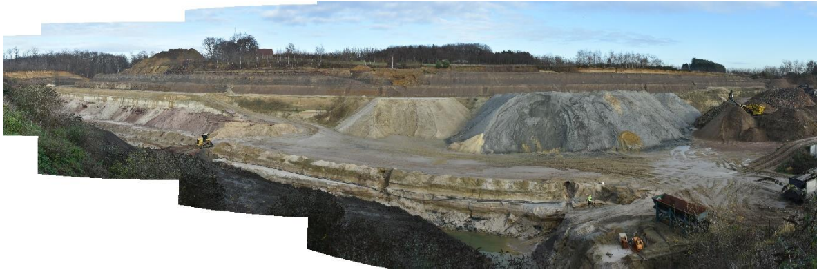
Figuur 4. Overzicht van de groeve op 12/12/2018, met op de voorgrond het bassin op niveau -1, uiterst links wand 1 en over de geheel breedte wand 8. Foto genomen vanaf het midden van de groeve richting noord-noordoosten. Foto F_VLA17-4-1-003-OV-01.
