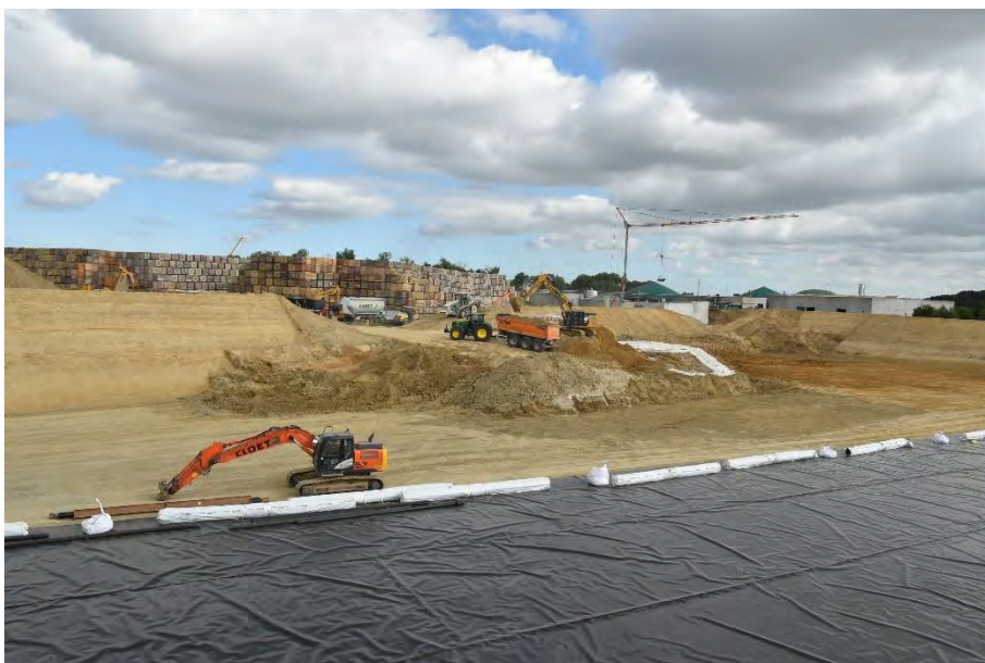
Figuur 5. Zicht over de westelijke helft van de put: graafwerkzaamheden in uitvoering (dd. 21/6/2018; F_VLA17-4-1-002-ALG-042).
