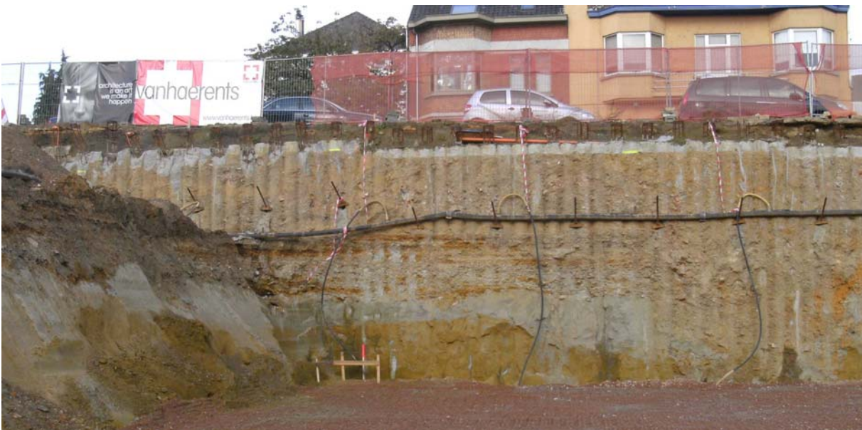
2. algemeen zicht op de wand van de ontsluiting op 22 oktober 2009
