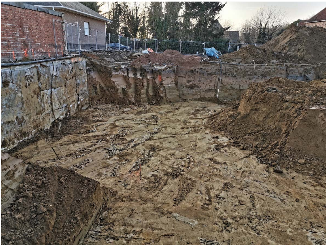
Foto 3. Zicht op de westwand van de bouwput langs de zuidzijde met betonnen muur. Merk op dat de kakibruine verkleuring niet met dezelfde intensiteit doorheen de wand optreedt en mogelijk verband houdt met hoger zandgehalte. Op de bodem van de bouwput zijn scheuren getrokken in de stijve klei, waartegen kleine brokken klei en zand accumuleren (foto M. Duser, 26.1.2020).
