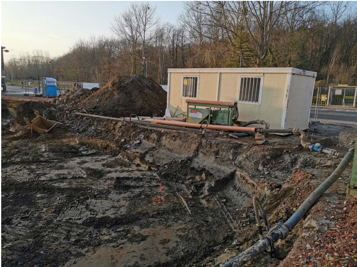
Foto 1. Zicht op de uitgraving aan de noordzijde van de bouwput tegen de Leuvensesteenweg. De blauwgrijze klei wordt afgesneden door bruin kleiig-stenig ophogingsmateriaal onder de steenweg, zonder tussenkomst van Quartaire deklagen (foto M. Duser, 26.1.2020).
