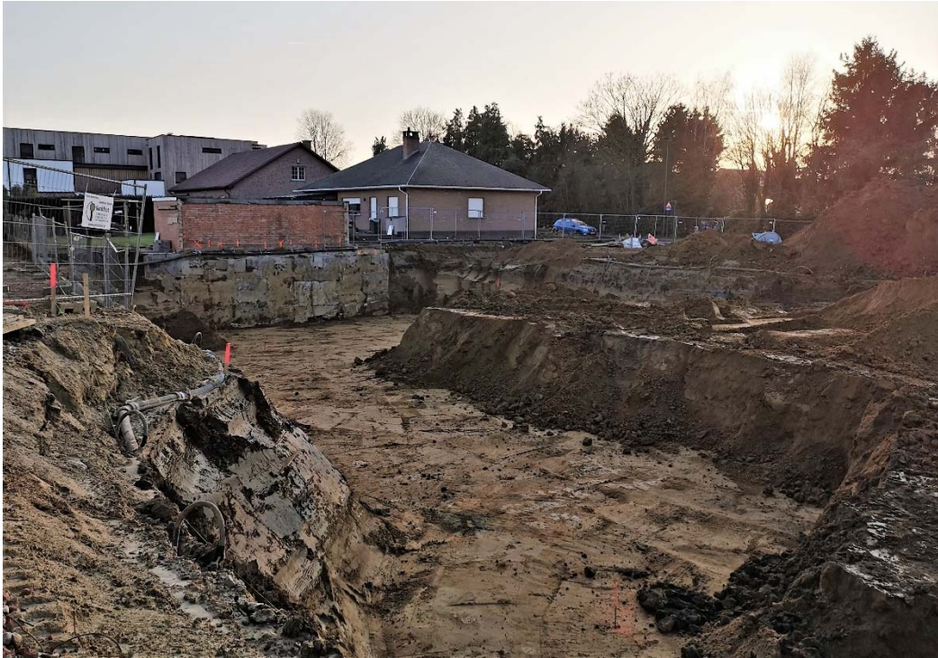
Foto 2. Zicht op de bouwput richting zuid, met ca 1 m bruine verspoelde leem of colluvium, rustend op de stijve grijze, kakibruin oxiderende klei (foto M. Duser, 26.1.2020).
