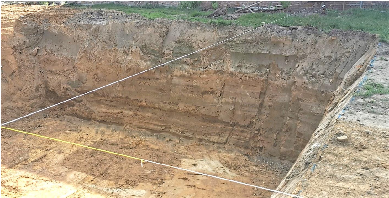
Zuidoostelijke wand van bouwput, eveneens met dezelfde lagenopbouw.
