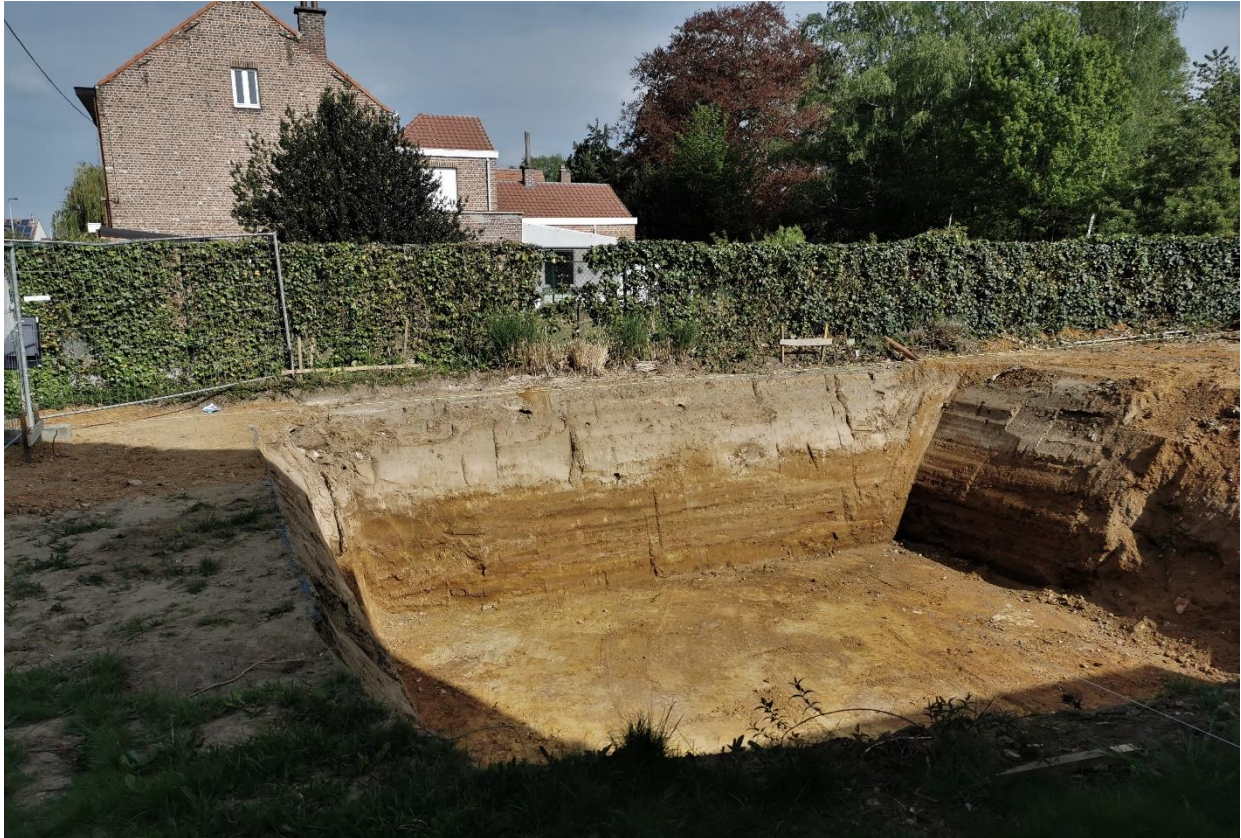
Bouwput Van Rodestraat 10, Kessel-Lo, zicht vanop de straat in de richting van de noordwestelijke wand dwars op de straat gericht, met twee onderscheiden laagpakketten.
