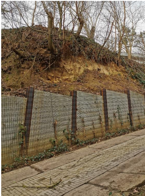
Foto 2ab. Inrit naar Kortrijksestraat 377 Kessel-Lo met bleek lemig zand, colluviaal verspoeld, zonder aanwijzing voor Zand van Diest of ijzerzandsteen, wijzend op oppervlakte-afspoeling op het bovenliggende plateau.
