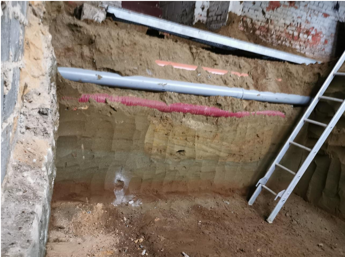
Foto 1. Uitgraving kelder Kortrijksestraat 359A te Kessel-Lo in ongestoord Zand van Diest met beperkte roestverkleuring. Dit uitzicht blijft behouden tot vlak tegen huidig straatniveau, wat aantoont dat de holle weg een (sub)recent erosief fenomeen is.
