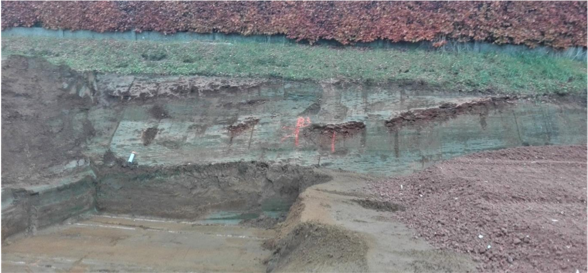
Foto 8. Zicht op de oostwand van de bouwput en de kleine uitgraving, waarin doorsneden door witte kleilaminaties de strekking van de sedimentaire afzetting aangeven (N10W). In de wand komen ijzerzandsteenlagen voor met schijnbaar noordwaartse afhelling van 10° die onafhankelijk lijkt van de sedimentaire structuur in de diepere uitgraving, dus een getuigenis kan zijn van uitgesproken trough cross-bedding, maar mogelijk een weergave is van de Quartaire pedogenese. Deze ijzerzandsteenlagen bestaan uit een opstapeling van limonietconcreties die echter geen continue steenbank vormen (foto M. Dusar, 26.11.2019).
