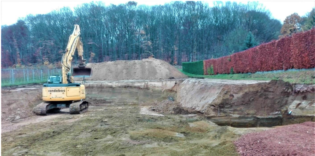
Foto 1. Overzicht bouwput, links wijngaard, rechts haag langs woning nr 24, op de achtergrond het Bleekbos, beeld genomen van de Nachtegalenstraat richting bos; rechtsvoor diepere uitgraving (foto M. Duser, 26.11.2019).
