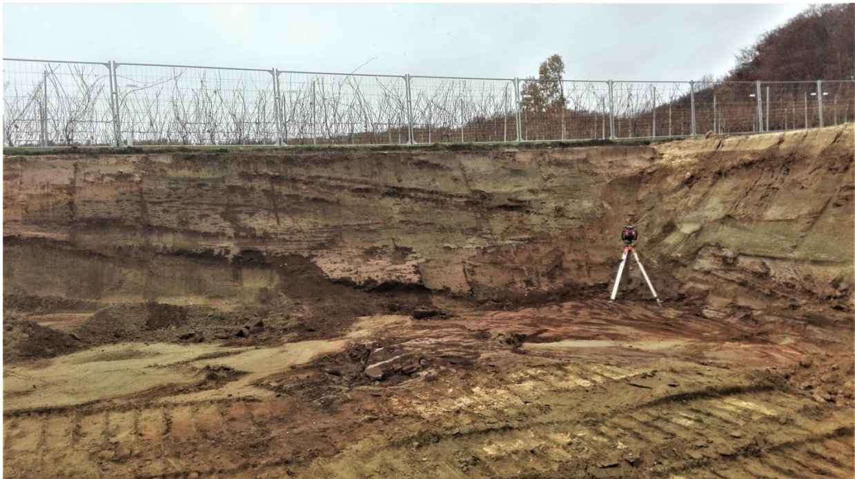
Foto 2. Noordwestelijke hoek van de bouwput (westelijke talud volgens richting N12W, noordelijke talud volgens richting N85E), met uitgraving vrijwel geheel in het Zand van Diest, met regelmatige 5°N afhellende foresets, gevolgd door verijzeringshorizonten, met bovenaan laagjes, vaak in doubletform, van samengegroeide concreties, en met onderaan, ter hoogte van de voet van de laser, een dikkere en meer homogene ijzerzandsteenbank. E sedimentaire helling in quasi loodrecht op elkaar staande richtingen wijst op een systeem van 'trough cross bedding' als belangrijkste sedimentaire structuur in de architectuur van get Zand van Diest (info Rik Houthuys) (foto M. Duser, 26.11.2019).
