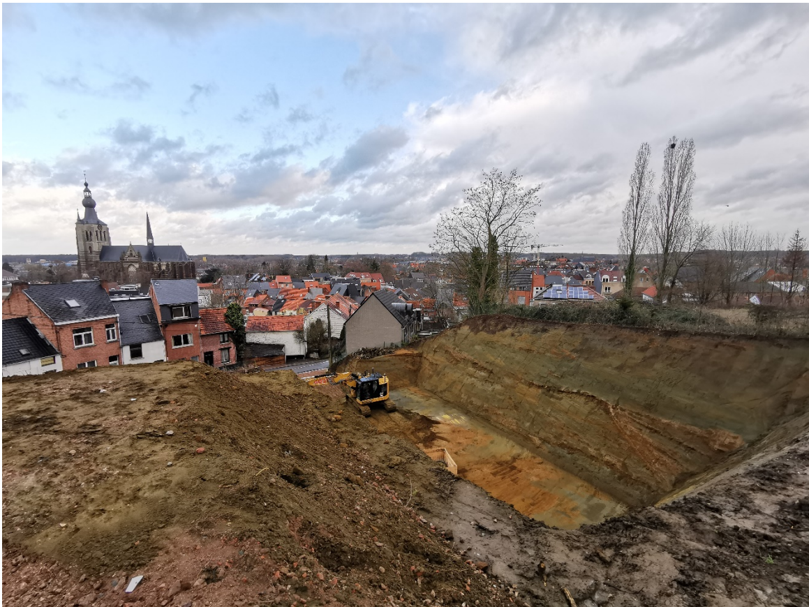
Foto 1. Overzicht bouwput vlak bij het lager gelegen centrum van Aarschot, met de Maaldersstraat onderaan de ingang van de bouwput, oplopend links uit beeld tot op de hoogte waarop de foto is genomen.
