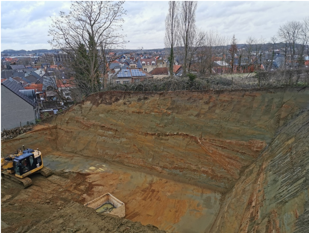
Foto 2. Zicht op oostelijke NNW-SSE gerichte wand van de bouwput, waarin een tweedeling is op te merken, gescheiden door een ijzerzandsteenlaag.
