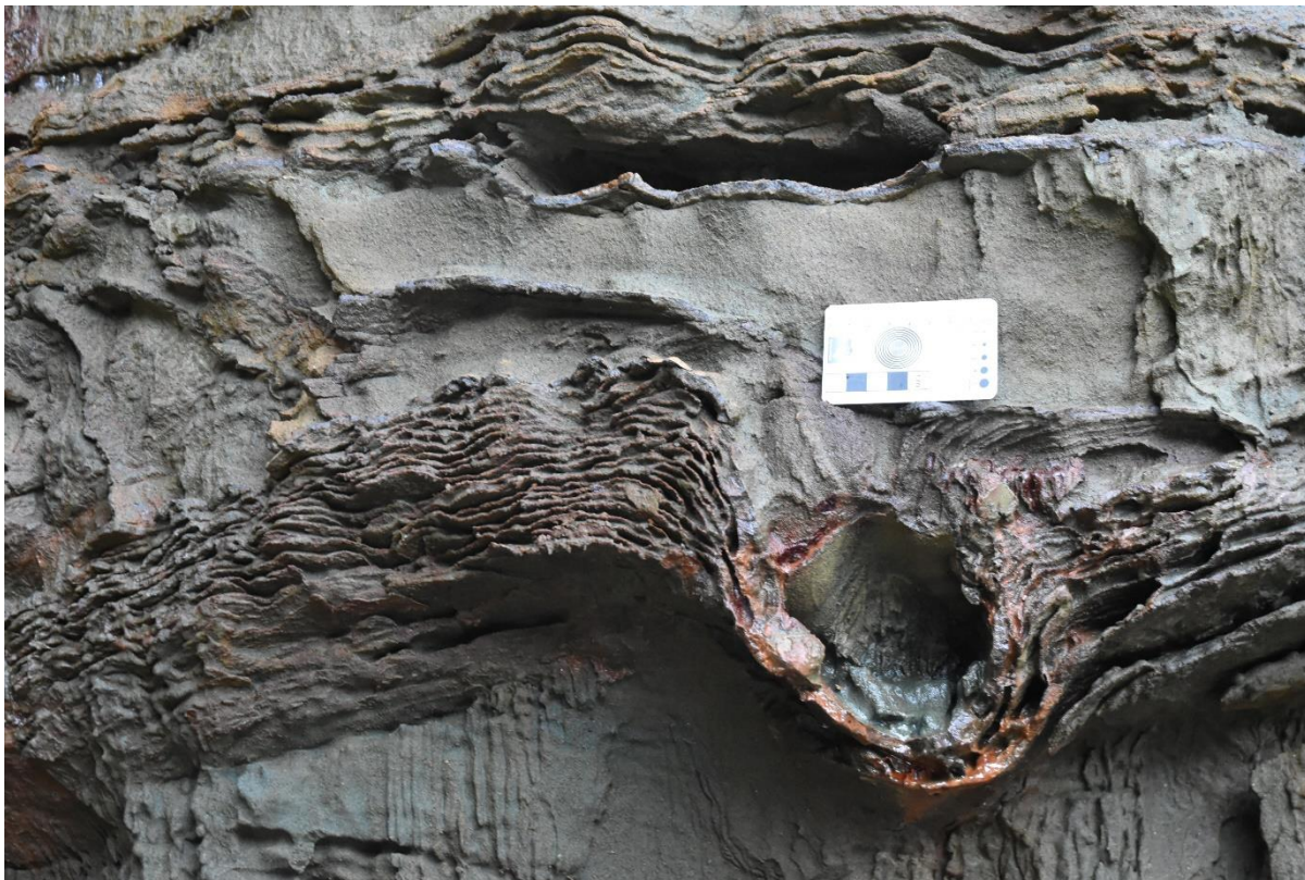
Figuur 7. Detail in wand 1 van uitverweerde goethietschillen. In deze pakketten, onderaan de ontsluiting, zijn weinig tot geen sedimentaire structuren zichtbaar. Foto F_VLA17-4-1-004-W1-05, zie ook foto's W1-03 en W1-04.
