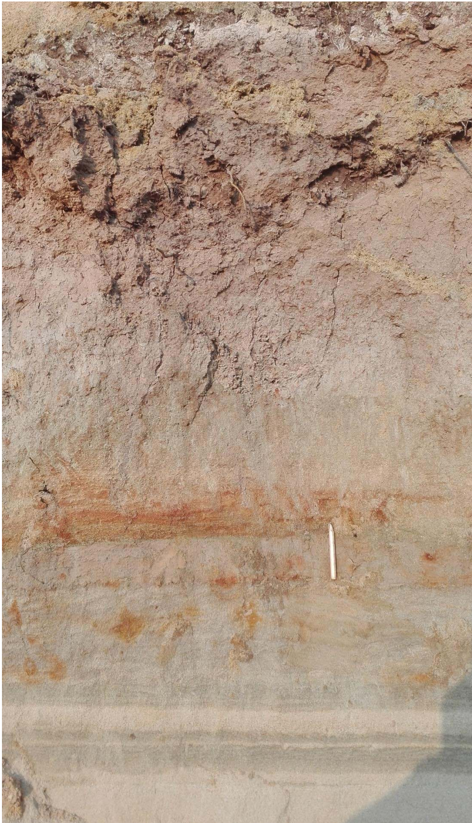
Bouwput Schotelveldstraat 4-6 Wilsele, overzicht op de bovenste lagen, gaande van opgehoogde grond (helemaal boven bleekgrijs en geel), de bodem (bruin, met verticale barsten), en het bovenste floodplain gedeelte van de Formatie van Arenberg.
