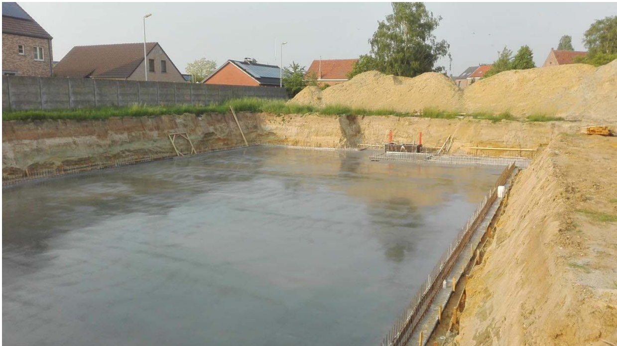
Overzicht bouwput Schotelveldstraat 4-6 Wilsede; profiel opgenomen in SE hoek (rechts achter in beeld).
