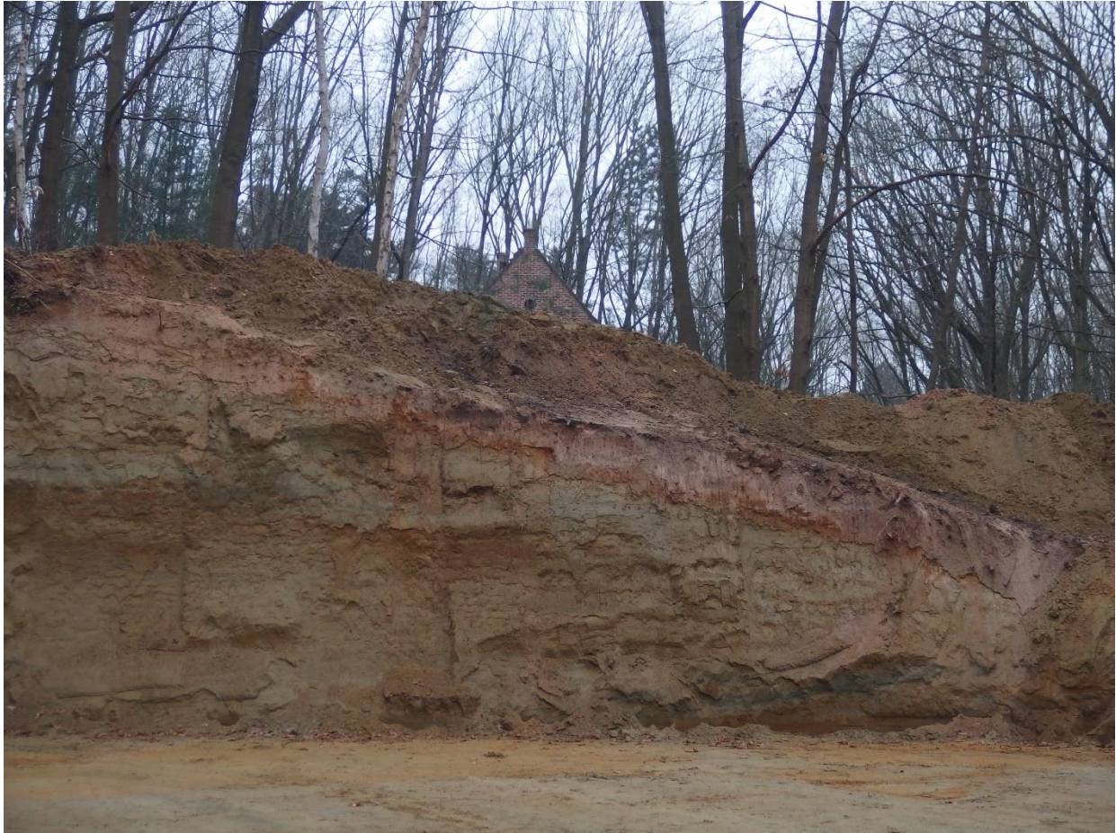
Foto 18. Bouwput Kwikstaartweg 72 Rotselaar, zicht op zuidwestwand (rechterwand van de uitgraving gezien vanaf de straat), met colluvium dat volgens de helling van de heuvel de onderliggende groene zanden en de verweringslaag discordant afdekt. De ongelijke basis van het colluvium is deels gevolg van uitvloeiing langs de groevewand.
