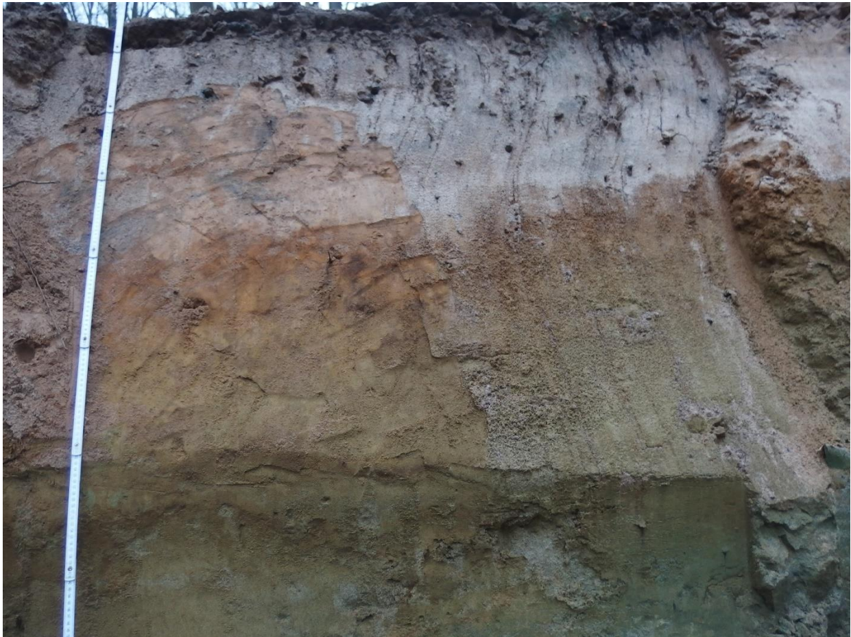
Foto 20. Bouwput Kwikstaartweg 72 Rotselaar. Detail van foto 19. Podzolbodem met bovenaan gebleekte asgrijze uitlogingshorizont, rijk aan zwart verpoederd wortelhout, volgens scherp lateraal contact overgaand in verroeste uitlogingshorizont, roestgrens gelijkend op een breukvlak. De textuur B horizon is vlekkelig oranje verkleurd, wijzend op een weinig geëvolueerde bodem. De redoxgrens (overgang van oranje naar groen) is tot stand gekomen in een vroegere verweringsfase, daterend van voor de insnijding en is evenmin gewijzigd in positie door de bodemvorming, alhoewel de groene zone structuurloos is geworden.
