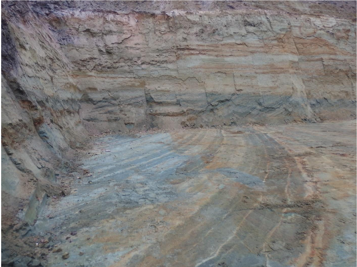
Foto 4. Bouwput Kwikstaartweg 72 Rotselaar. Sedimentaire opeenvolging in de regelmatig afhellende groene laag is in meer detail waar te nemen op de bodem van de bouwput, met opeenvolging van bleekgroene en groene lagen; in deze laatste komen zwartgroene laminaties voor (de jongste lagen komen voor linksachter op de foto) .
