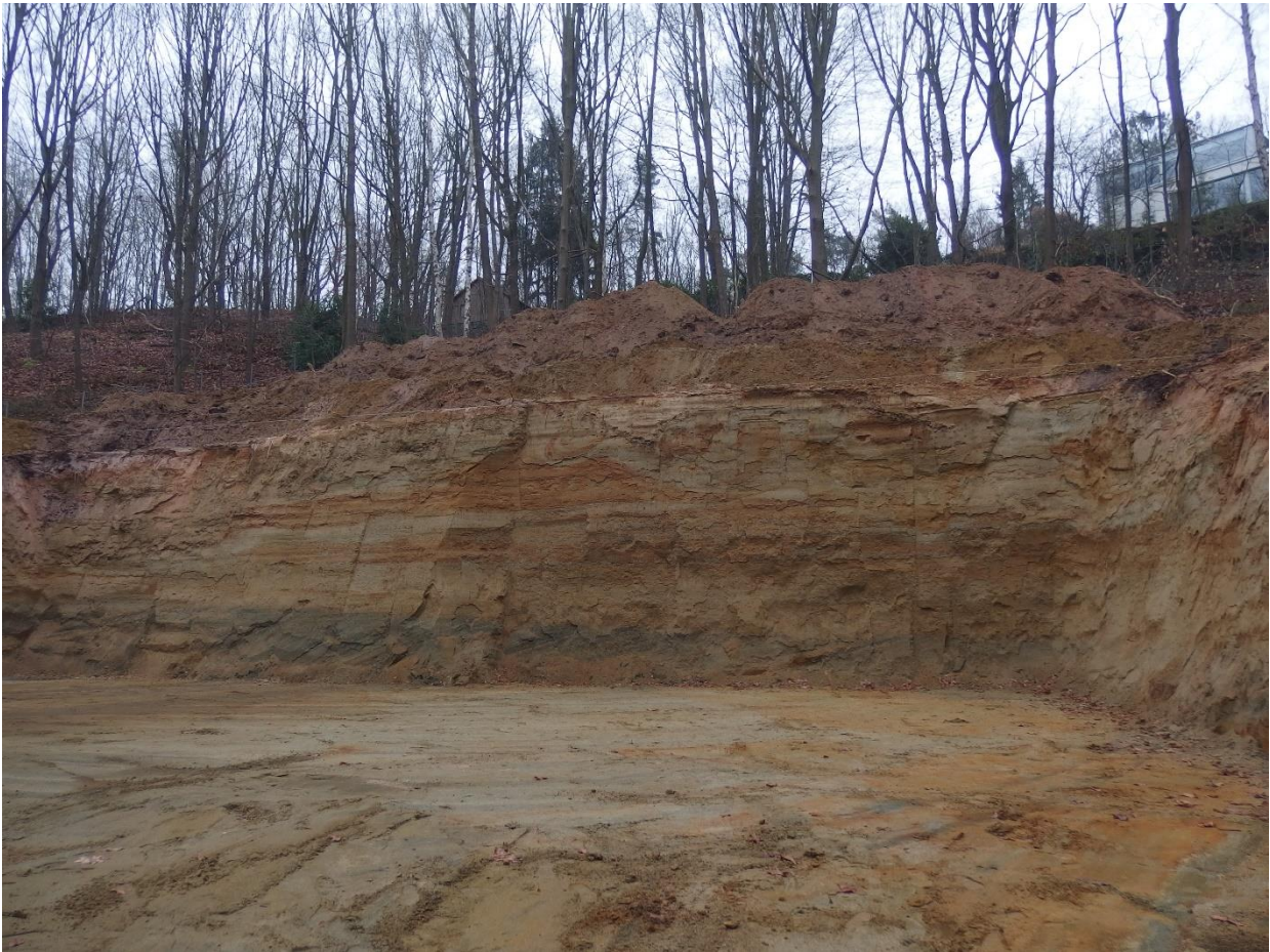
Foto 1. Bouwput Kwikstaartweg 72 Rotselaar, zicht op zuidoost- en zuidwestwanden, 17.12.2016. De steilwand is geheel in de Formatie van Diest, met een scherpe redox grens tussen zand met de oorspronkelijk sedimentaire kenmerken onderaan en de regoliet bovenaan. De groene laag onderaan heeft een hoogte van 1,75 m.
