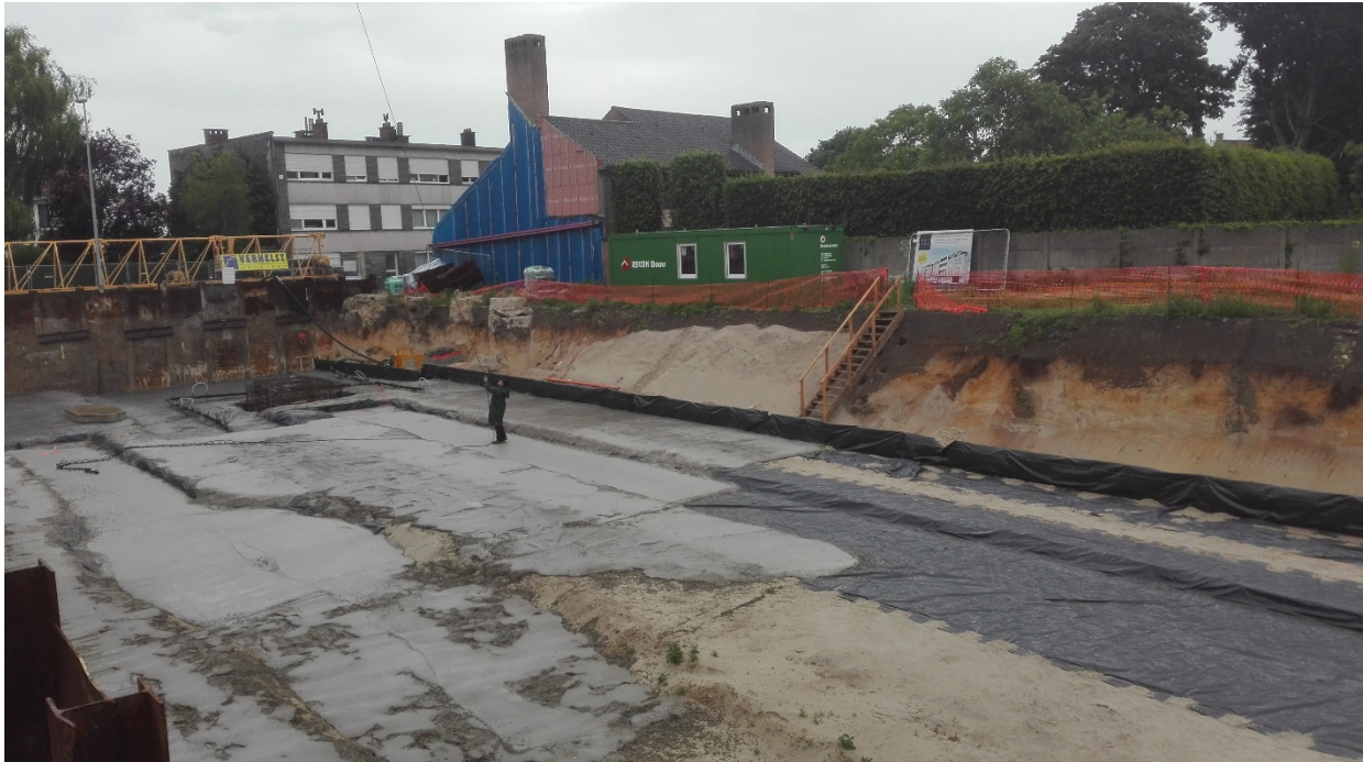
Overzicht op bouwput, zicht richting Kaaistraat; natuurlijke ontsluiting rechts van trap en in verste hoek van de bouwput (foto MD, 7.6.2019).
