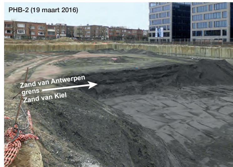
Fig. 7: PHB-2 werd tot op een diepte van 7 m uitgegraven, waarbij het contact tussen het zand van Kiel en het Zand van Antwerpen duidelijk zichtbaar werd, 2 m boven de bodem van de put. De basis van het Zand van Antwerpen bevat veel klei en schelpen, waardoor het door de wind veel minder gemakkelijk geërodeerd en dus duidelijker geaccentueerd wordt. De basis golft hier lichtjes op enkele plekken.
