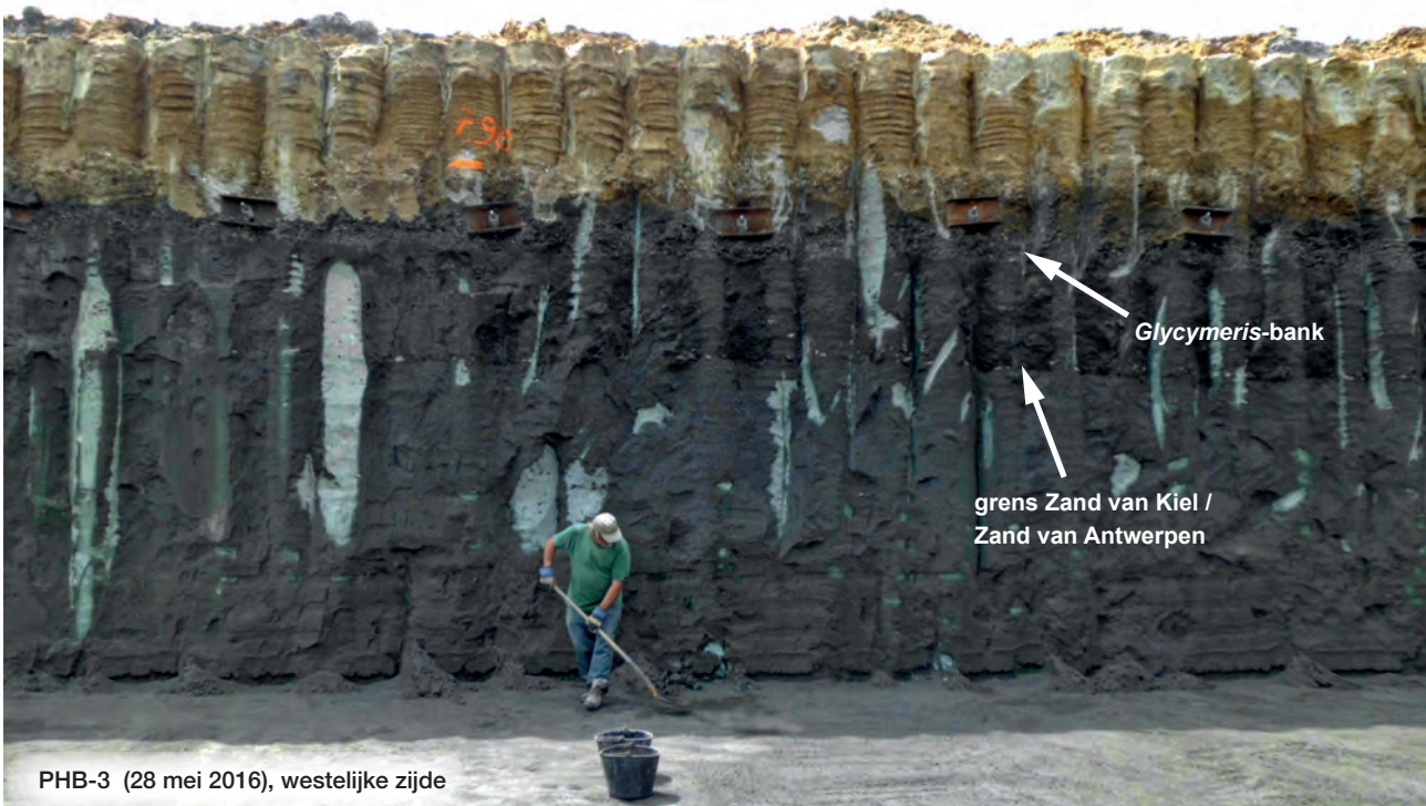
Fig. 16: PHB-3: zuidwestelijke zijde van de bouwput met grens Zand van Kiel / Zand van Antwerpen en Glycymeris -bank.
