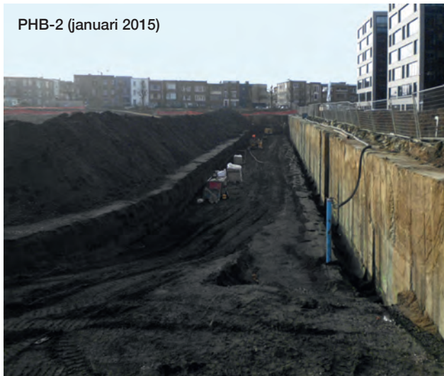
Fig. 2: Graafwerken PHB-2 in januari 2015. Het volledige post-Mioceen is reeds weggegraven tot op een diepte van ongeveer 3 m. Op het talud werd Zand van Antwerpen van verschillende niveaus door elkaar gestockeerd.
