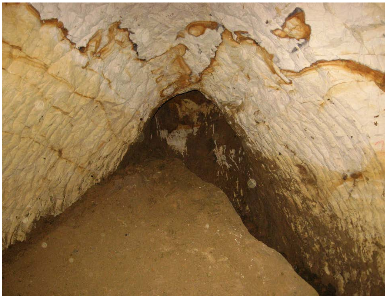
Marnière Huynen, ancienne galerie d'accès, remblayée (photo M. Dusar, 19.4.2013).
