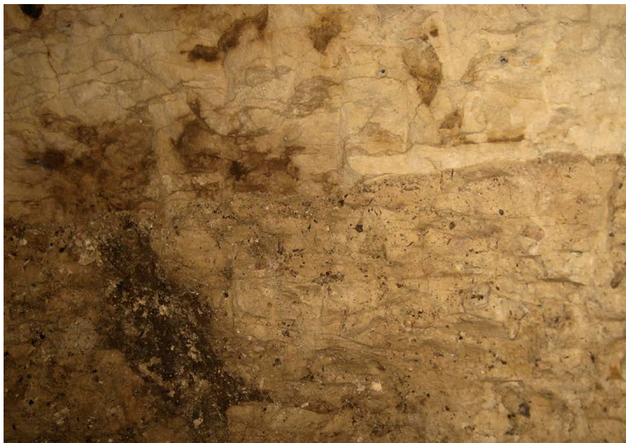
Marnière Huynen, traces de détritus de bois sur les paroi dans une zone d'inondation récente (photo M. Duser, 19.4.2013).
