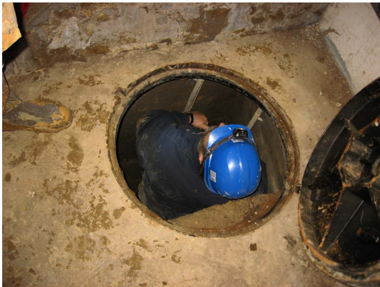
Accès par puits dans la propriété Huynen (photo M. Duser, 19.4.2013).
