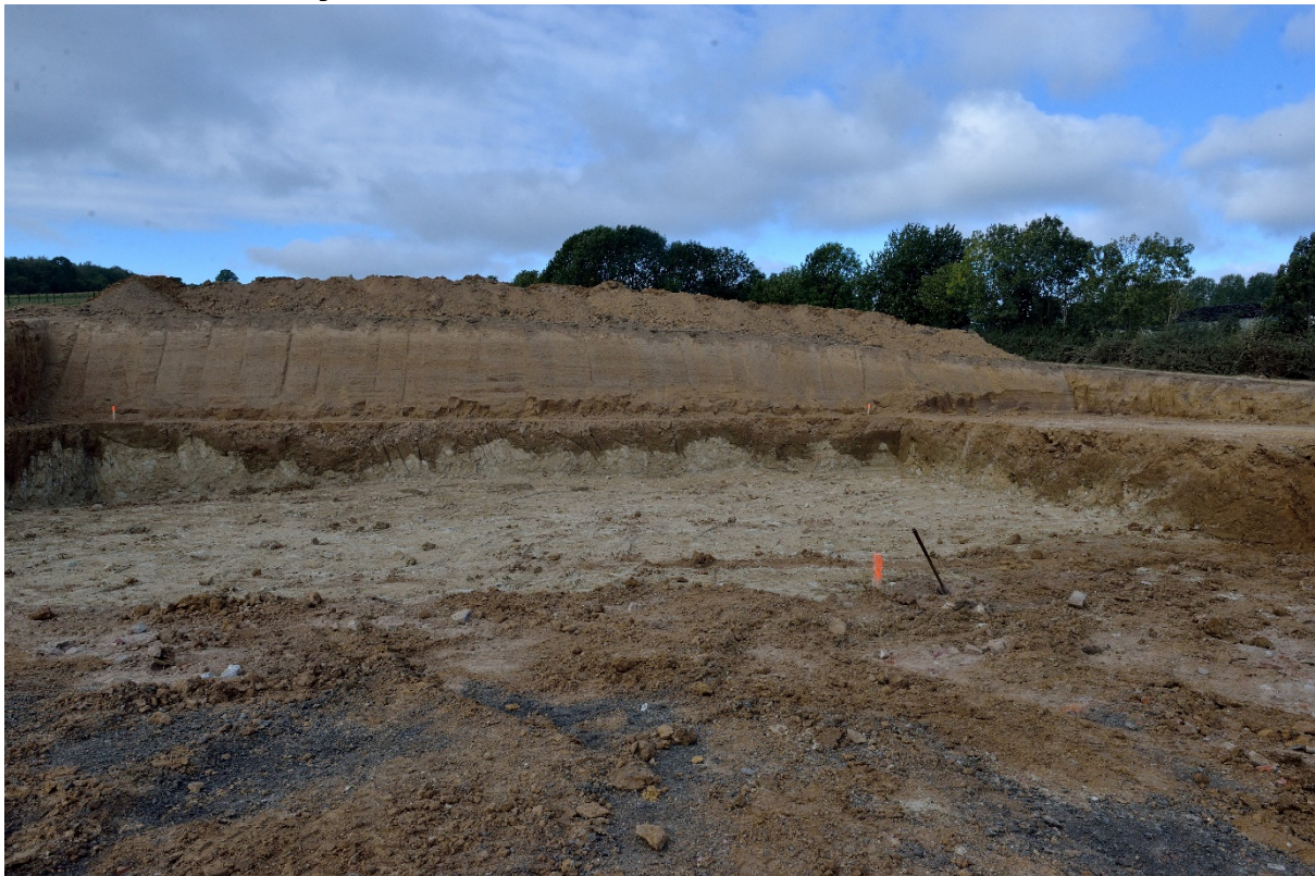
Noordoostelijke hoek van de bouwput (met zicht op westelijke wand) met donker grijs-groene zandige klei afgeschraapt van de bodem, aanwijzing voor contact
