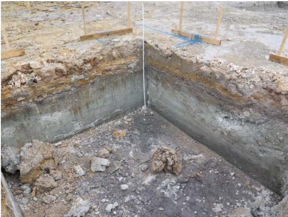
Foto E. Top van de Klei van Henis in de bodem van de bouwput; overgang van grijsgroene naar donkergroene venige klei (foto R. Dreesen).
