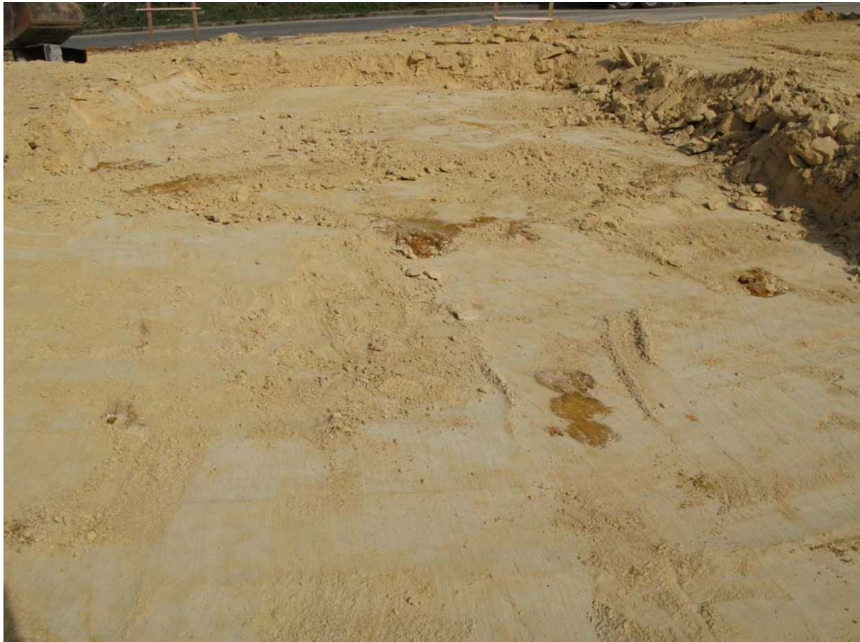
Foto bouwput Millerweg 5-7, uitgegraven in tufkrijt met doorsneden van aardpijpen (geologische orgelpijpen), foto Ludo Indeherberge 11.8.2015.
