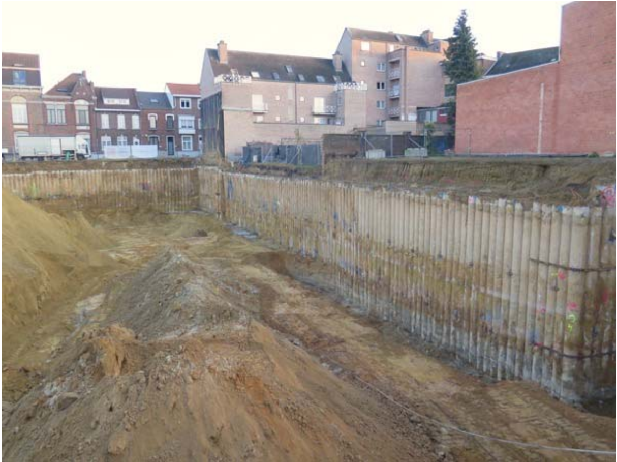
Foto 8 – zicht op zuidwand van bouwput met duidelijke horizontale gelaagdheid binnen eenheden B en C. Mooie kleurafwisseling (door relictten van sedimenten op beton) en zeer duidelijke bruinrode geoxideerde band (schommelingszone grondwatertafel?) vlak boven kleirijkere sedimenten. Volgende foto's zijn details van deze wand (midden van foto)
