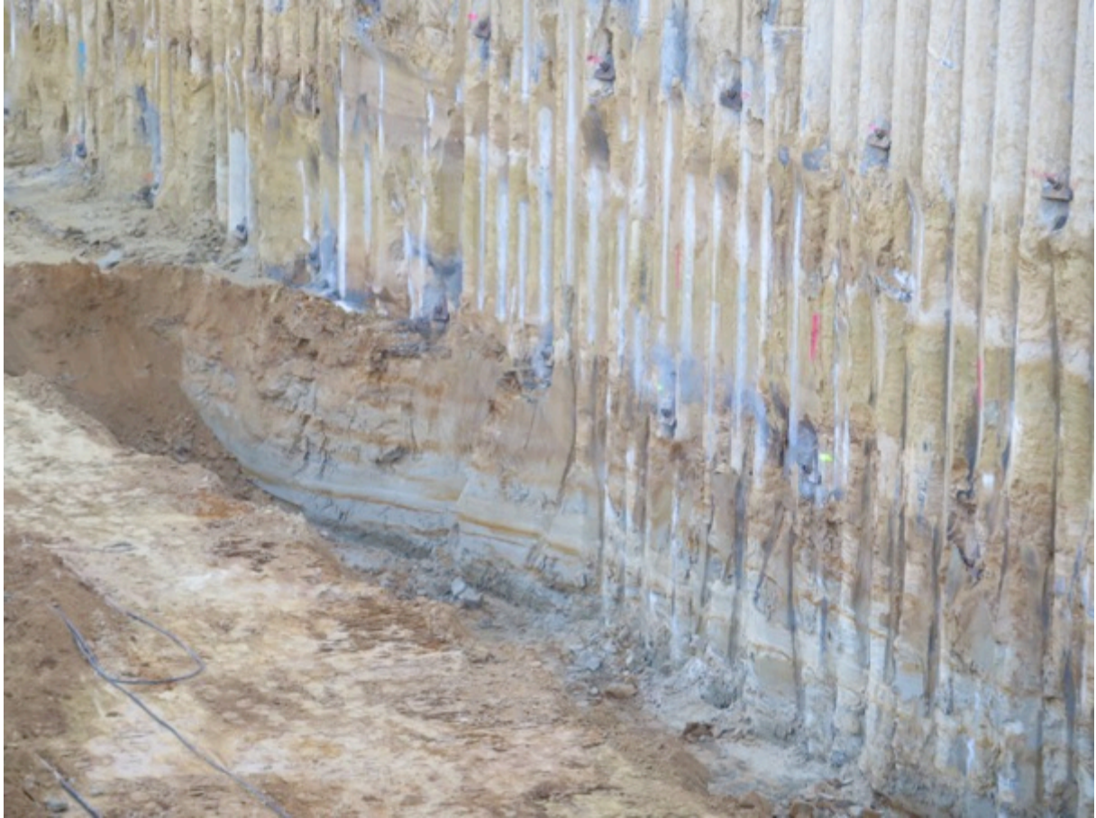
Foto 9: Detail van vorige foto. Zicht op roodbruine tot paarsig rode oxidatiezone aan basis van eenheid B en vlak boven eenheid C (grijze klei) – ook nog oxidatielaagjes zichtbaar in meer zandige laagjes in de klei
