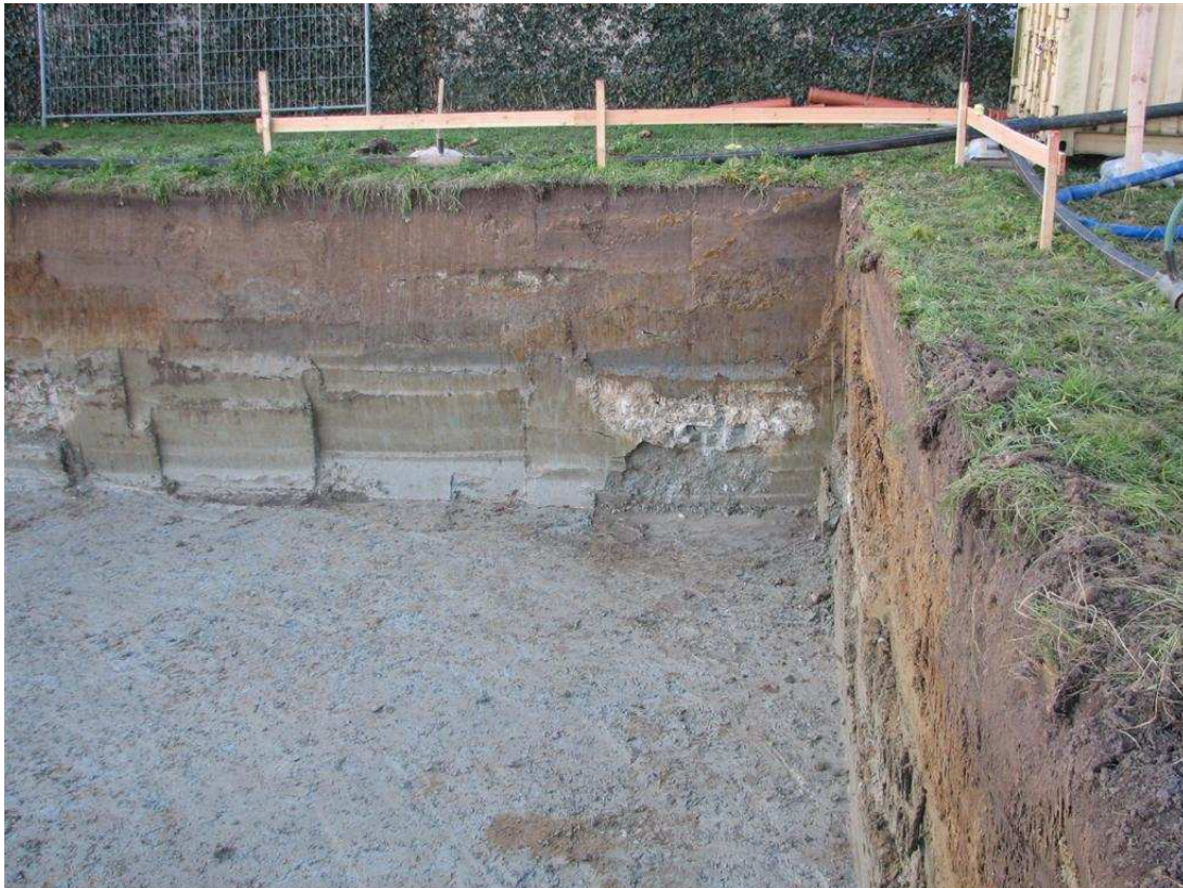
Overzicht bouwput met contact tussen Klei van Henis en Quartaire zandleemoverdekking (foto Alida Vanholst, LIKONA Werkgroep geologie).
