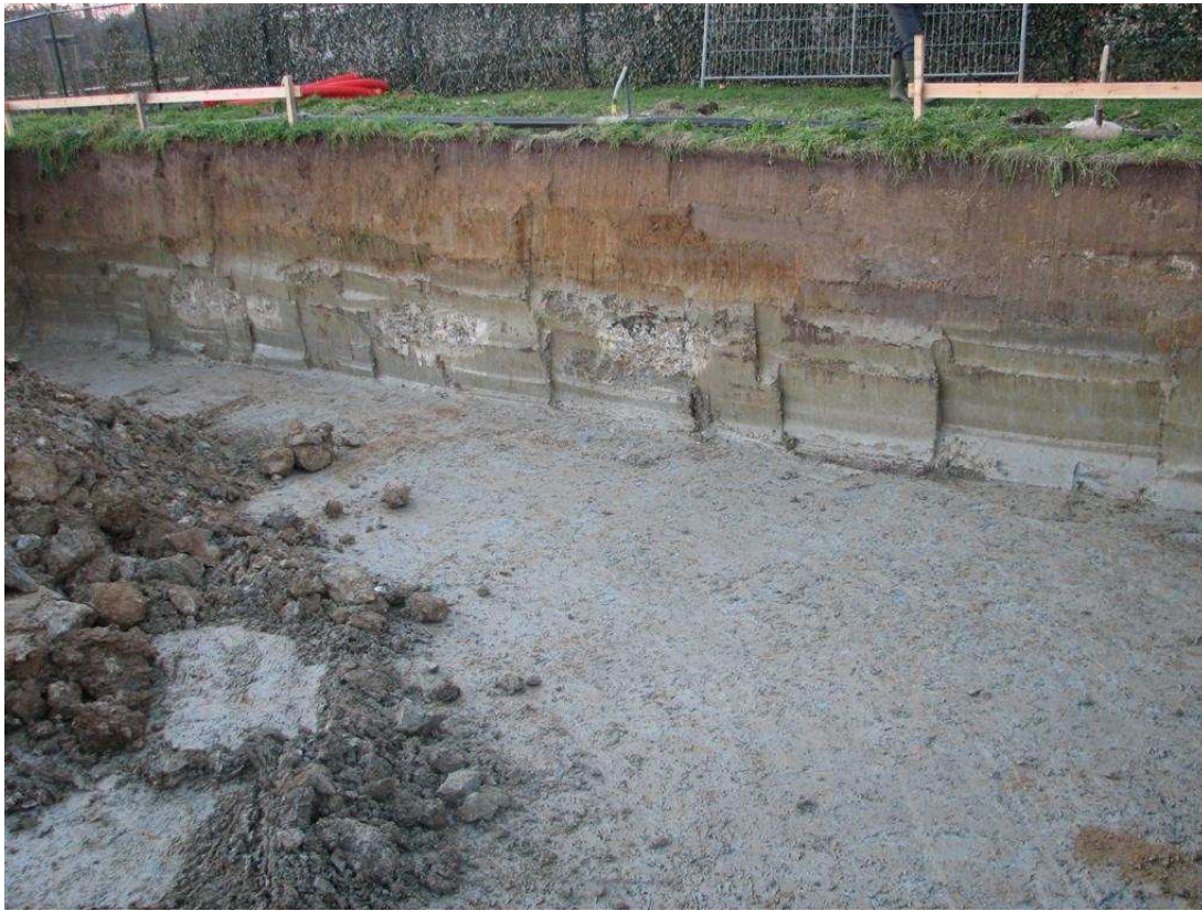
Overzicht bouwput met contact tussen Klei van Henis en Quartaire zandleemoverdekking vanuit andere hoek (foto Alida Vanholst, LIKONA Werkgroep geologie).
