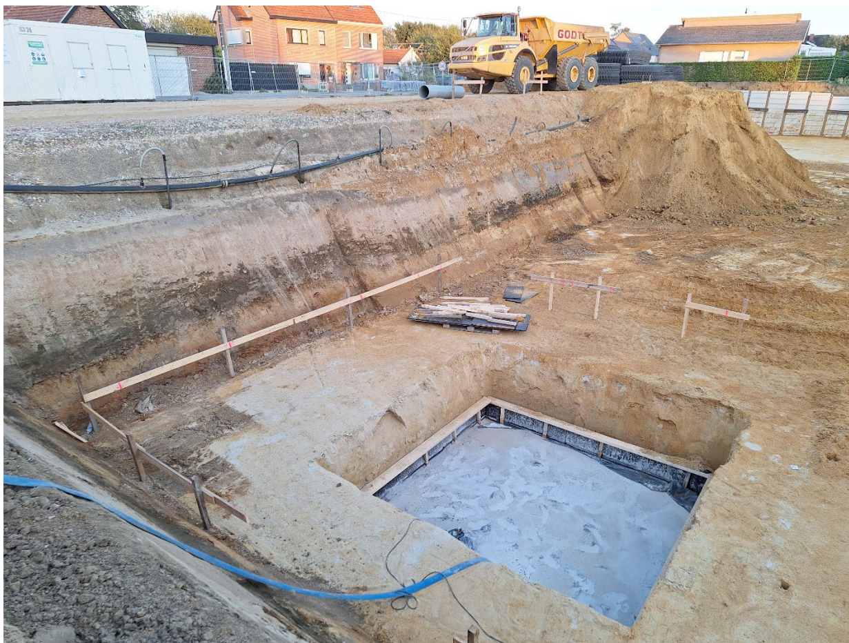
Talud langs de Oude Tiensebaan (oostzijde).
