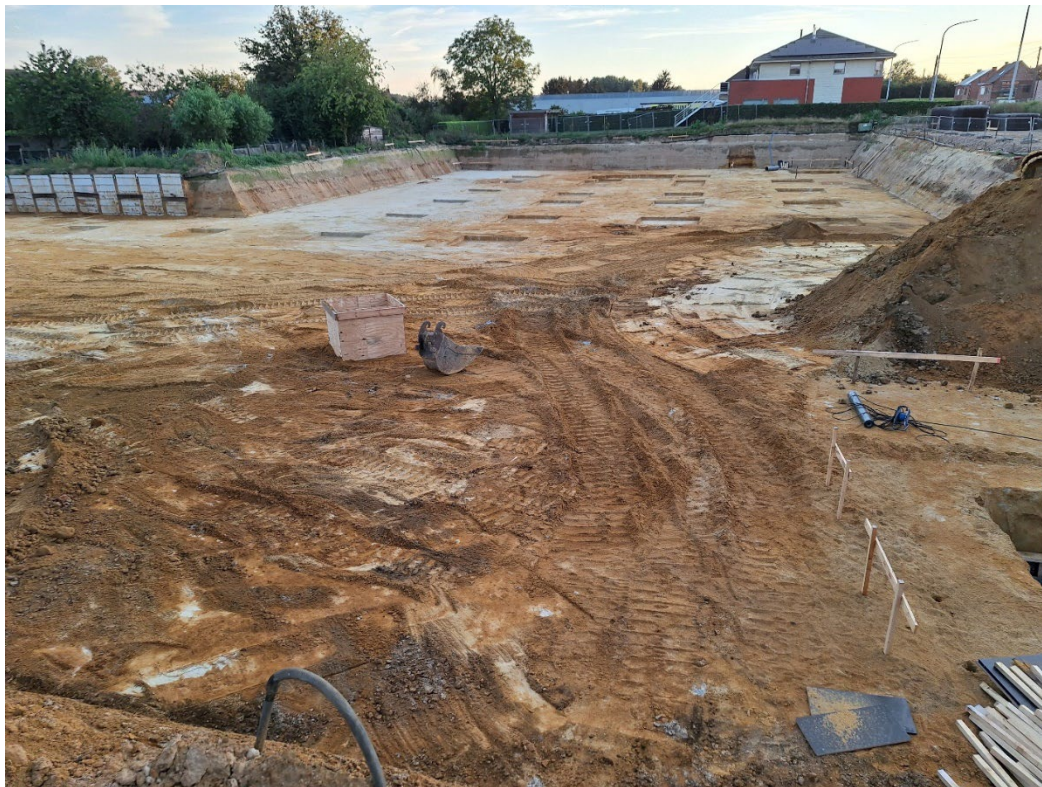
Overzicht bouwput, zicht naar westen parallel aan Leuvensesteenweg.
