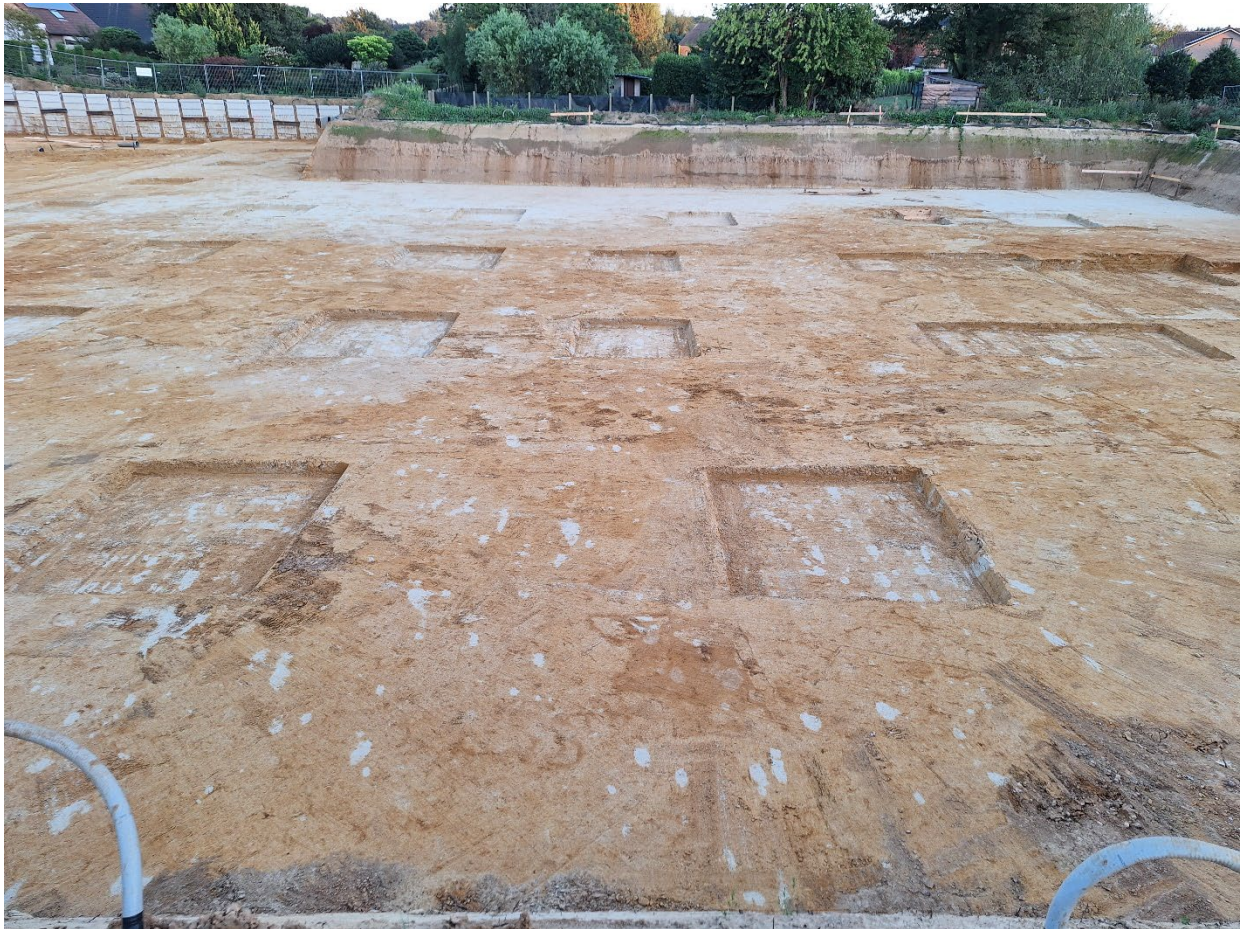
Op achtergrond talud tegenover de Leuvensesteenweg (aan zuidzijde); op voorgrond bouwputbodem in licht roestig verkleurd geel zand met witte reductievlekken.
