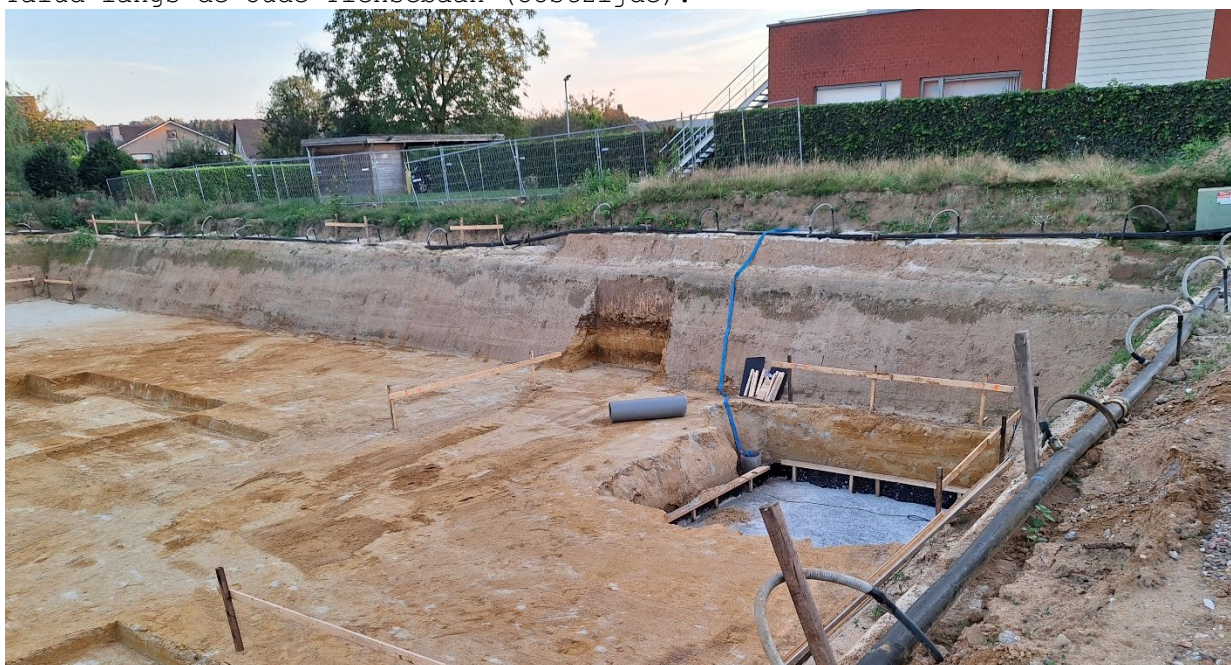
Talud dwars op de Leuvensesteenweg (westzijde).
