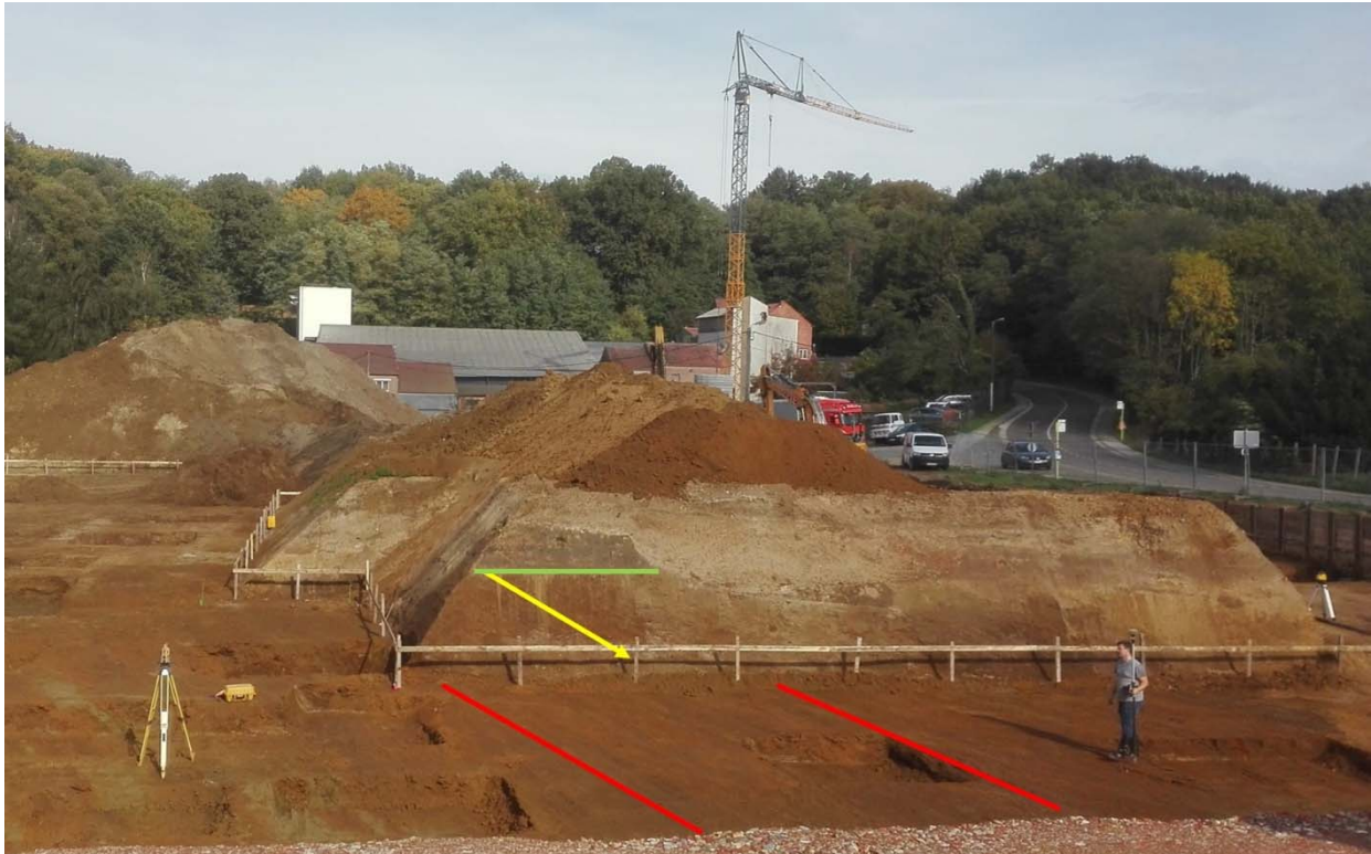
Figuur 6. Oostelijk deel van bouwput, met top Zand van Diest onder Anthropogene opvulling, aangeduid door de subhorizontale groene lijn, volgens contact verstoord door een verglijding. De richting van de gele pijl duidt de sedimentaire helling aan van de foresets. De rode lijnen op de bodem van de bouwput volgen bleek-donkergekleurde banding naargelang het glauconietgehalte van het zand volgens de richting van de gelaagdheid (= strekking).
