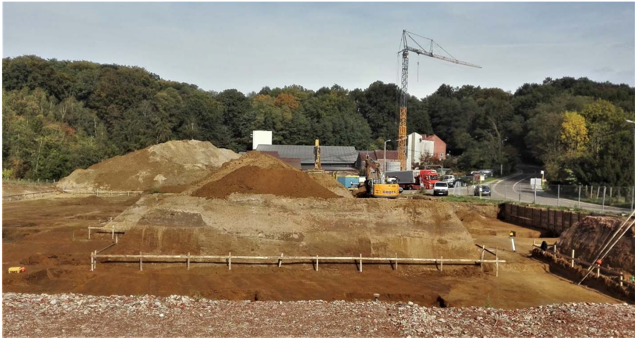
Figuur 4. Contact onderliggend Zand van Diest en bovenliggend Anthropogeen in oostelijk deel van bouwput, met verglijding van de vochtige (grijsgekleurde) sliblaag (ook Bt horizont) over ca 5 m en aanvulling met bovenliggend zand en bouwpuin.
