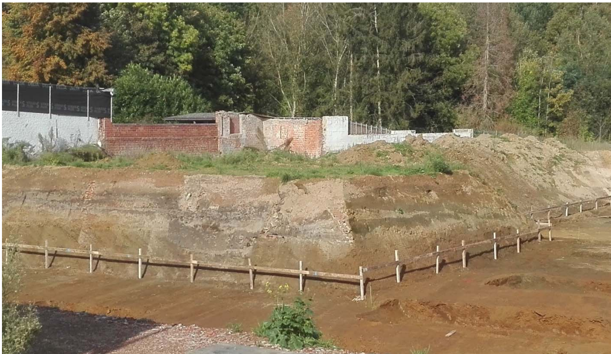
Figuur 3. Contact onderliggend Zand van Diest en bovenliggend Anthropogeen in westelijk deel van bouwput, met kleine 'slenk' in de (gedeeltelijk ontdebeldde) vochtige (grijsgekleurde) sliblaag (ook Bt-horizont) over ca 5 m en aanvulling met bovenliggend zand en bouwpuin.
