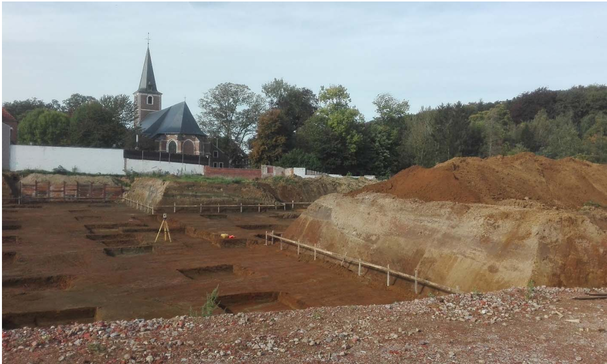
Figuur 2. Overzicht dieper gedeelte van de bouwput, gelegen langs de Leuvense Steenweg, gezien richting kerk, van oost naar west.
