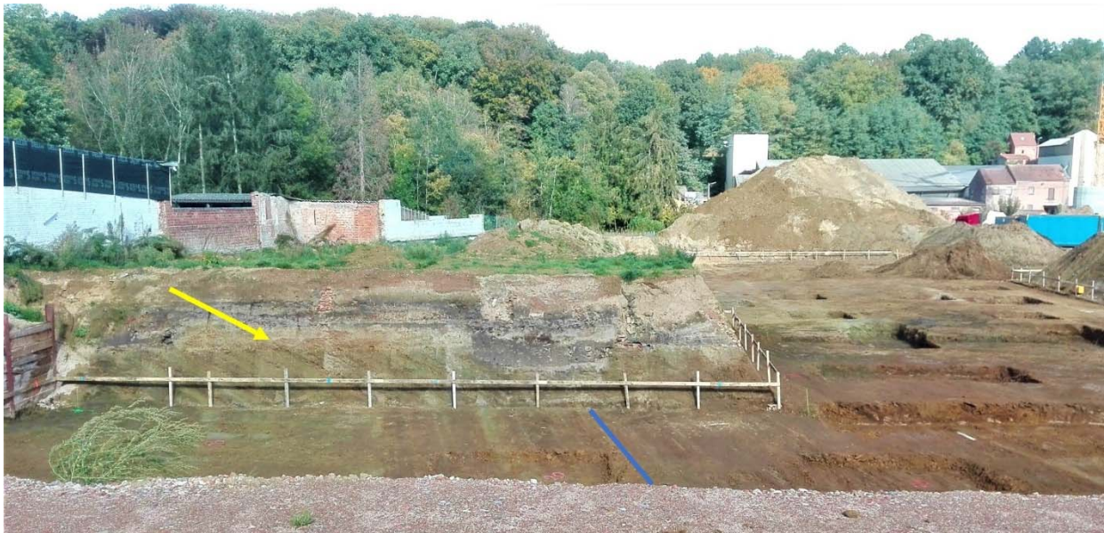
Figuur 5. Westelijk deel van bouwput, met top Zand van Diest onder Anthropogene opvulling (aangeduid door gele pijlpunt); contactvlak verstoord door een kleine slenk van anthropogene oorsprong. De richting van de gele pijl duidt de sedimentaire helling aan van de foresets. De blauwe lijn op de bodem van de bouwput volgt bleek-donkergekleurde banding naargelang het glauconietgehalte van het zand volgens de richting van de gelaagdheid (= strekking).
