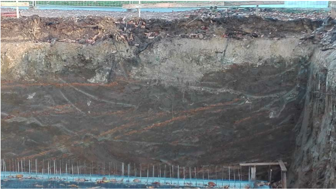
SE hoek van bouwput: Zand van Diest met limoniethorizonten zowel subhorizontaal volgens indringing van meteorische verwerking als steilhellend naar schijnbaar NE richting, onder uitlogingsbodem met boomwortels en strooisellaag.
