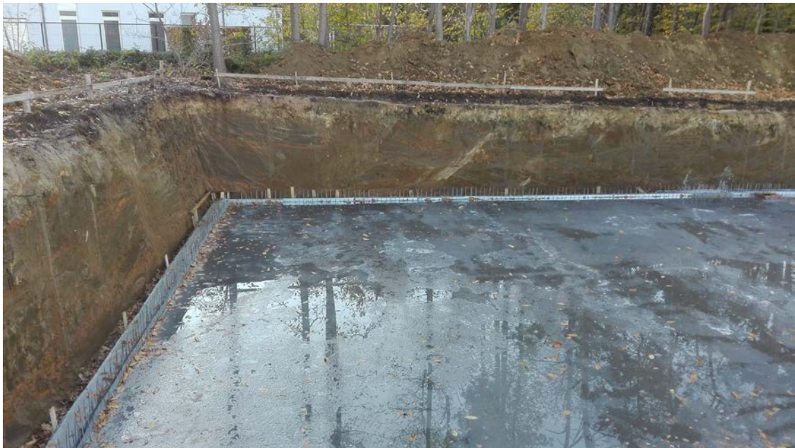
Zicht op SW hoek van bouwput met donkergroen Zand van Diest met oranje verweringshorizonten, onder lichtbruine rudimentaire bodem en recente strooisellaag.
