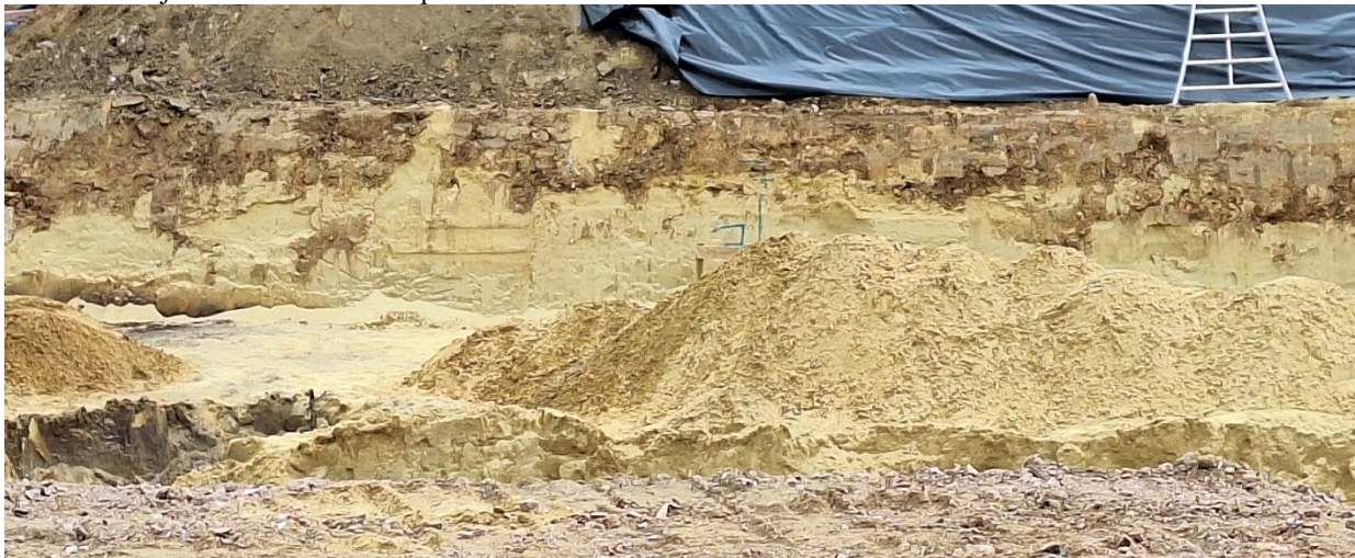
Noordwestelijke talud van de bouwput, uitvergroting. Bleekgeel Zand van Brussel in-situ en trapsgewijs gescheiden van geroerde bruine aanvulgrond door een steenlaagje, getuige van vroegere afgraving.
