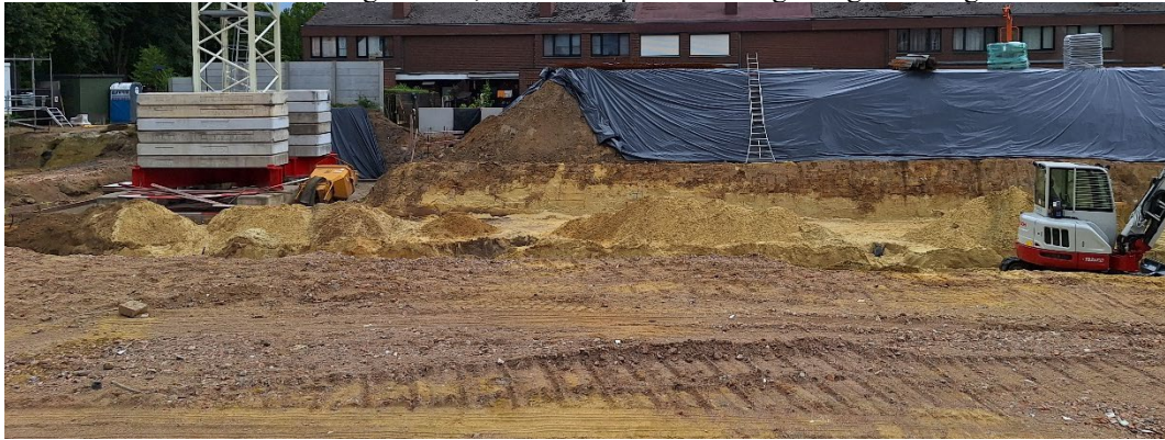
Noordwestelijke talud van de bouwput.
