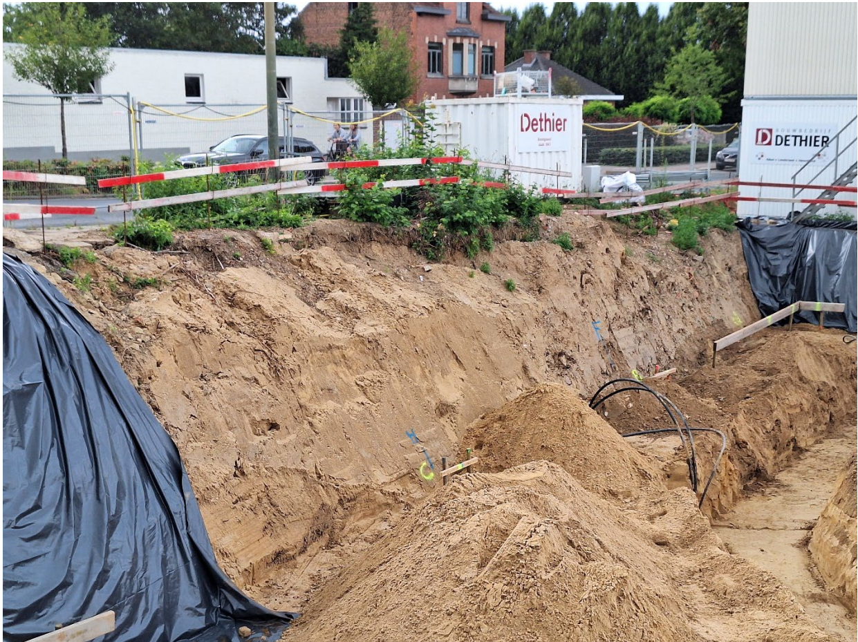
Zuidwestelijke talud van de bouwput. Vooraan aangebrachte grond, achterwand gestoord colluvium. Geoxideerd zand van brussel enkel in de sleuven en putten in de vloer van de bouwput.
