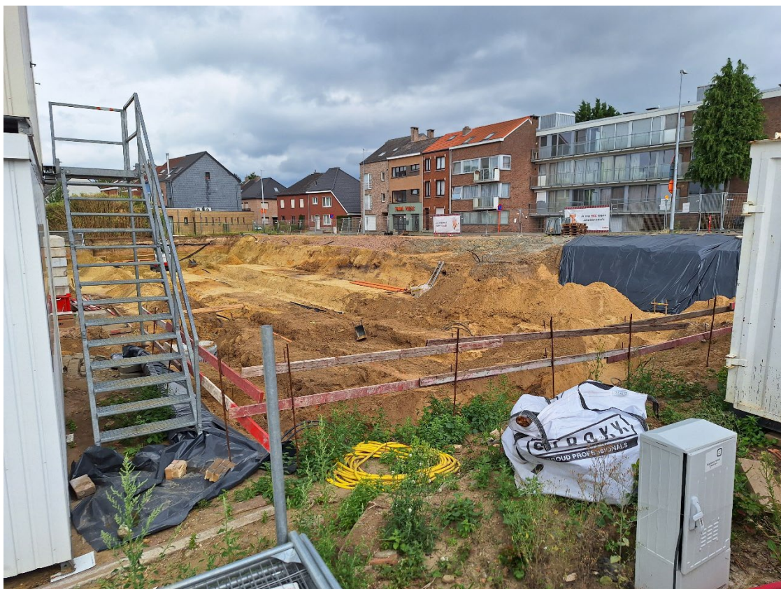
Overzicht bouwput langs de Platte Lostraat, zicht naar NE.
