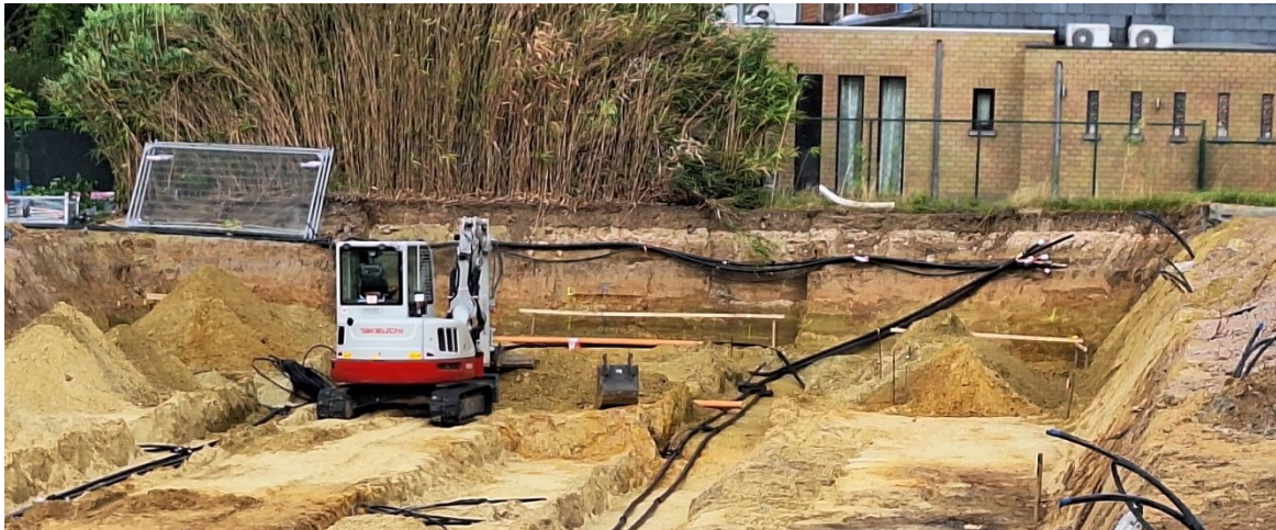
Noordoostelijke talud van de bouwput. Het ongeroerde Zand van Brussel, onderaan de bouwput, is gescheiden van de roodbruine opvuldgrond en stenige bovenlaag door een gestratificeerd pakket van geelbruin leemig zand met dunne intercalaties van zuiver geel zand, als natte depositie na uitgraving als zandgroeve.
