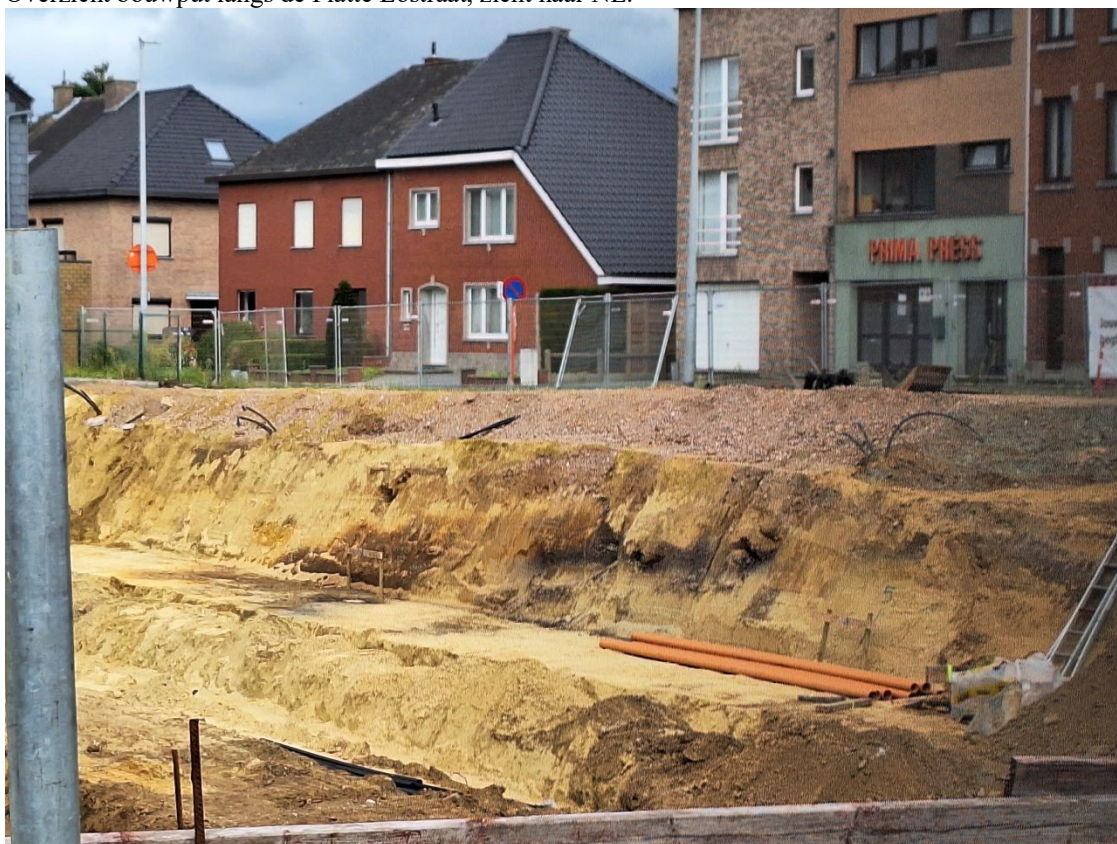
Zuidoostelijke talud van de bouwput. Onder afgegraven laag met bouwpuin geremanieerd Zand van Brussel, vermoedelijk opvulling van vroegere afgraving en gescheiden van donkerder geel compacter gestapeld in-situ zand door een bruinzwarte laag aangerijkt met asse als onderdeel van een hellend contact.
