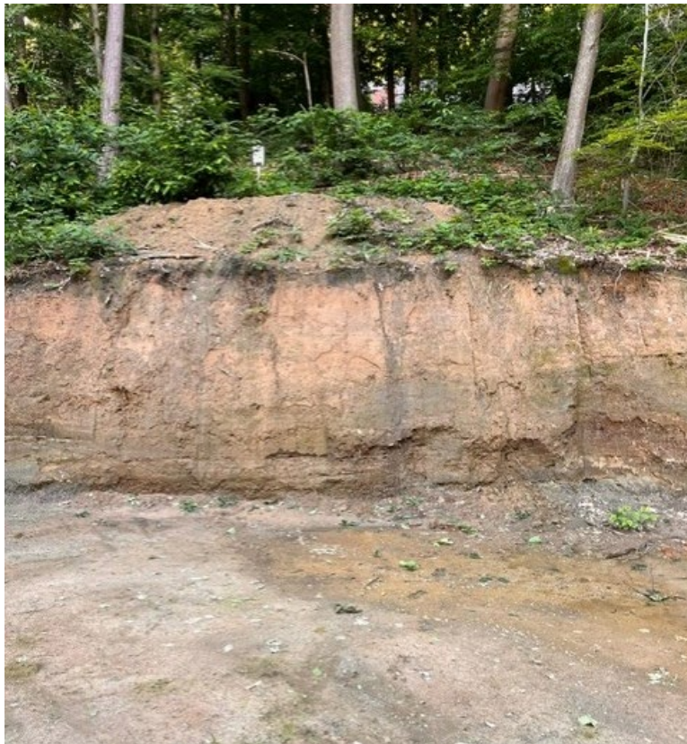
Bouwput tegen de steile Attenhovenberg, met grindlaag aan de basis van de uitgraving (foto Bart Vercoutere).
