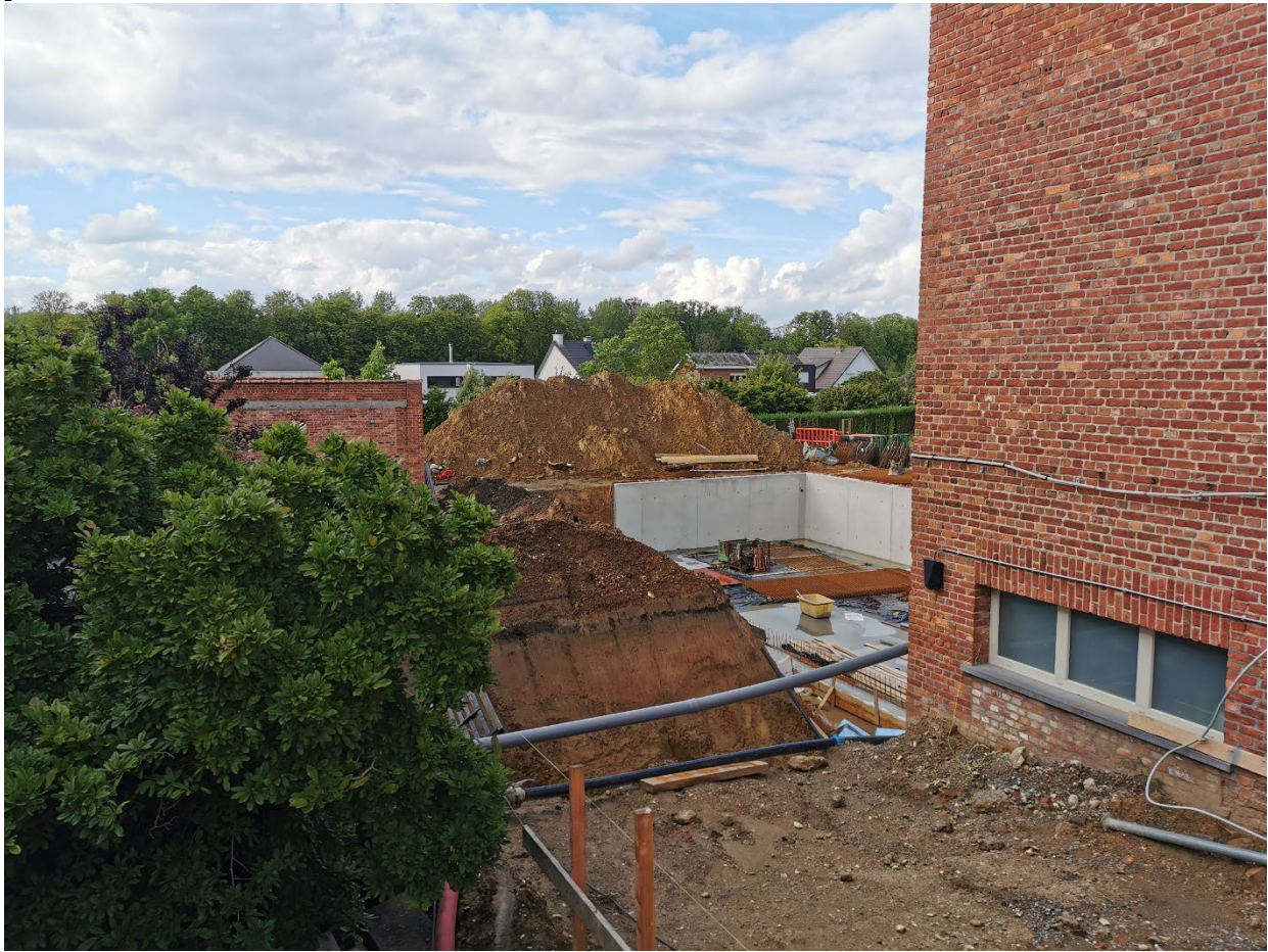
Zicht op bouwput voor De Chartreuse multidisciplinair centrum, gezien vanaf de Leuvensebaan naast nr 185 te Holsbeek.
