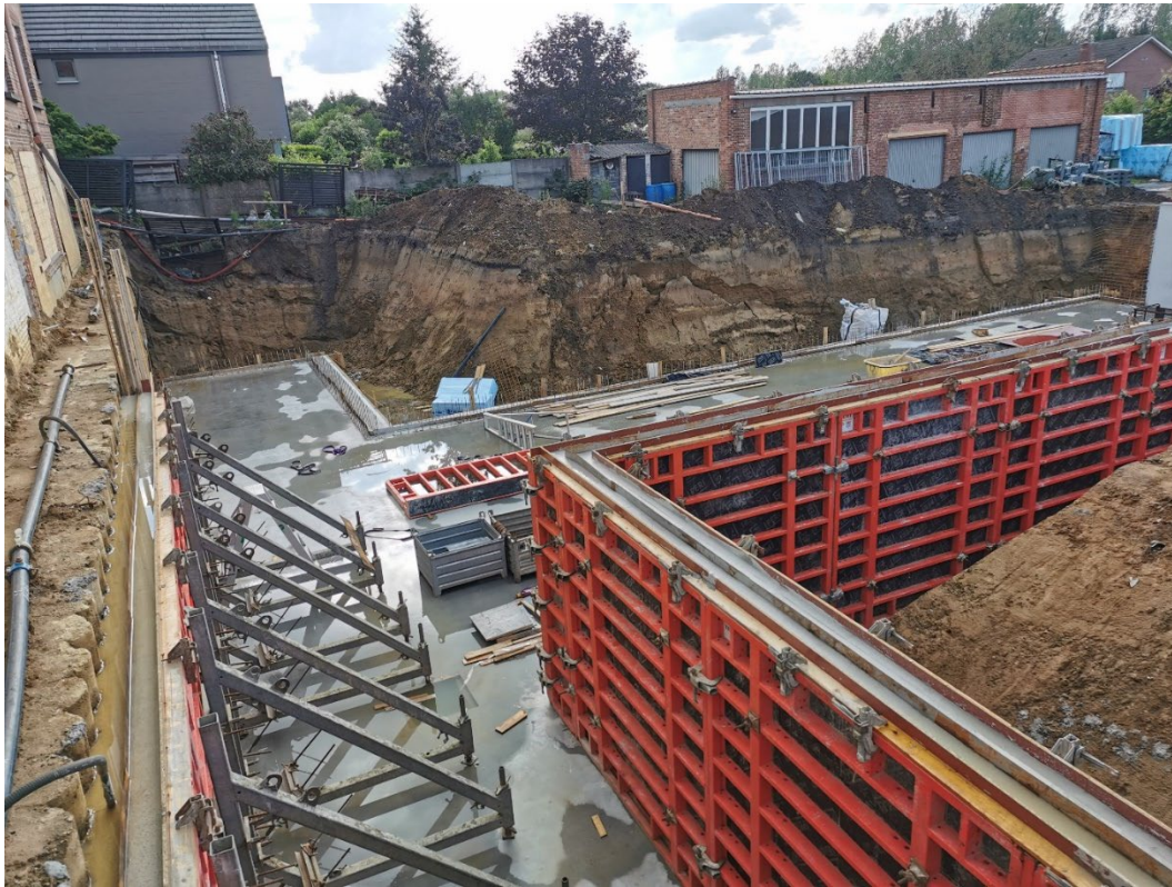
Bouwput voor De Chartreuse multidisciplinair centrum gezien vanaf achterkant Leuvensebaan 181 Holsbeek, met tot 6 m dik zandlemig colluvium afgezet in een puinkegel aan de voet van de Attenrodeberg.
