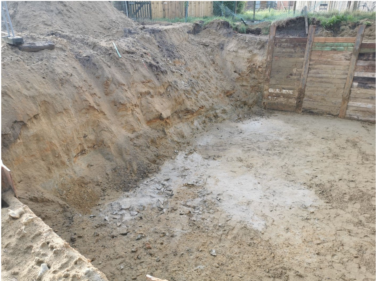
Zicht op de vrije oostwand van de bouwput met roestgeel zand onder het grijzere afgestorte zand en onderaan meer verkitte niveaus die een oosthelling vertonen; in de bodem van de bouwput komt bleekgeel zand voor.
