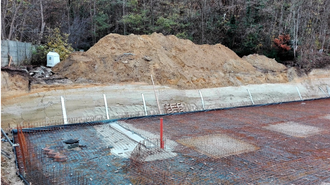
Overzicht op noordelijke achterwand van bouwput Kesselberg met geulvormige insnijding gevuld door colluvium(foto 29.11.2018)
