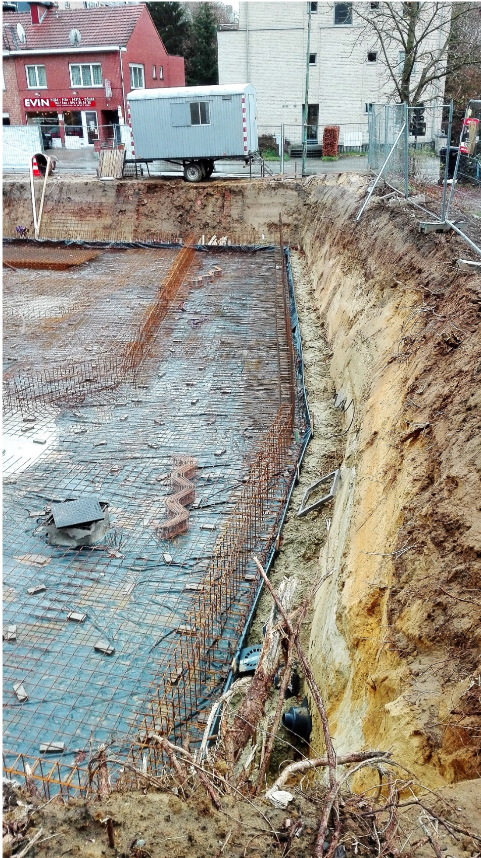
Zicht op de westelijke wand van de bouwput vanaf de Kesselseberg richting Wilselsesteenweg met onderaan nog wit Tongeriaanzand gevolgd door roestig geel lokaal groenig (en licht kleihoudend) zand, onregelmatig afgesneden
