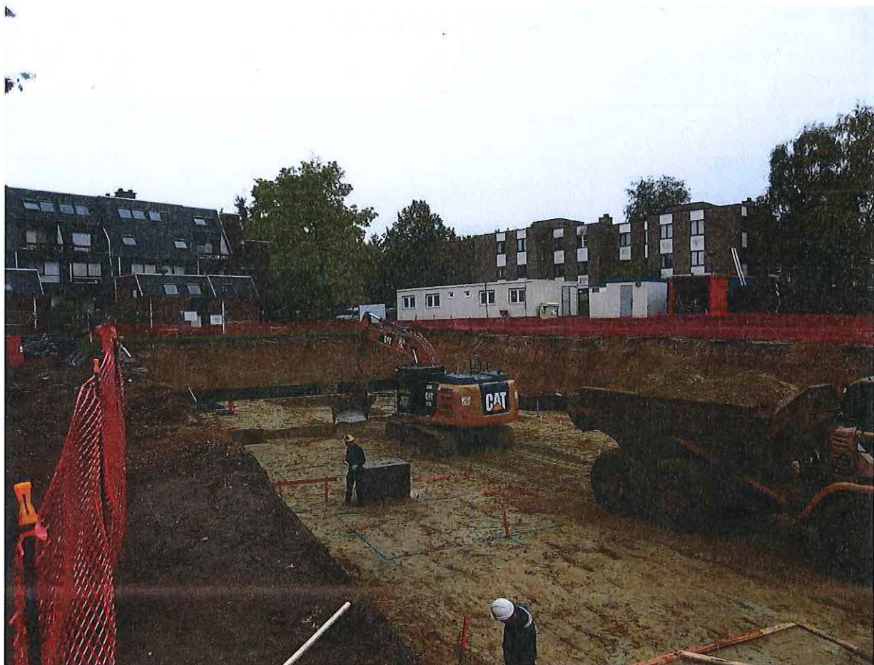
Zicht op deel van bouwput (foto 8.10.2015)
