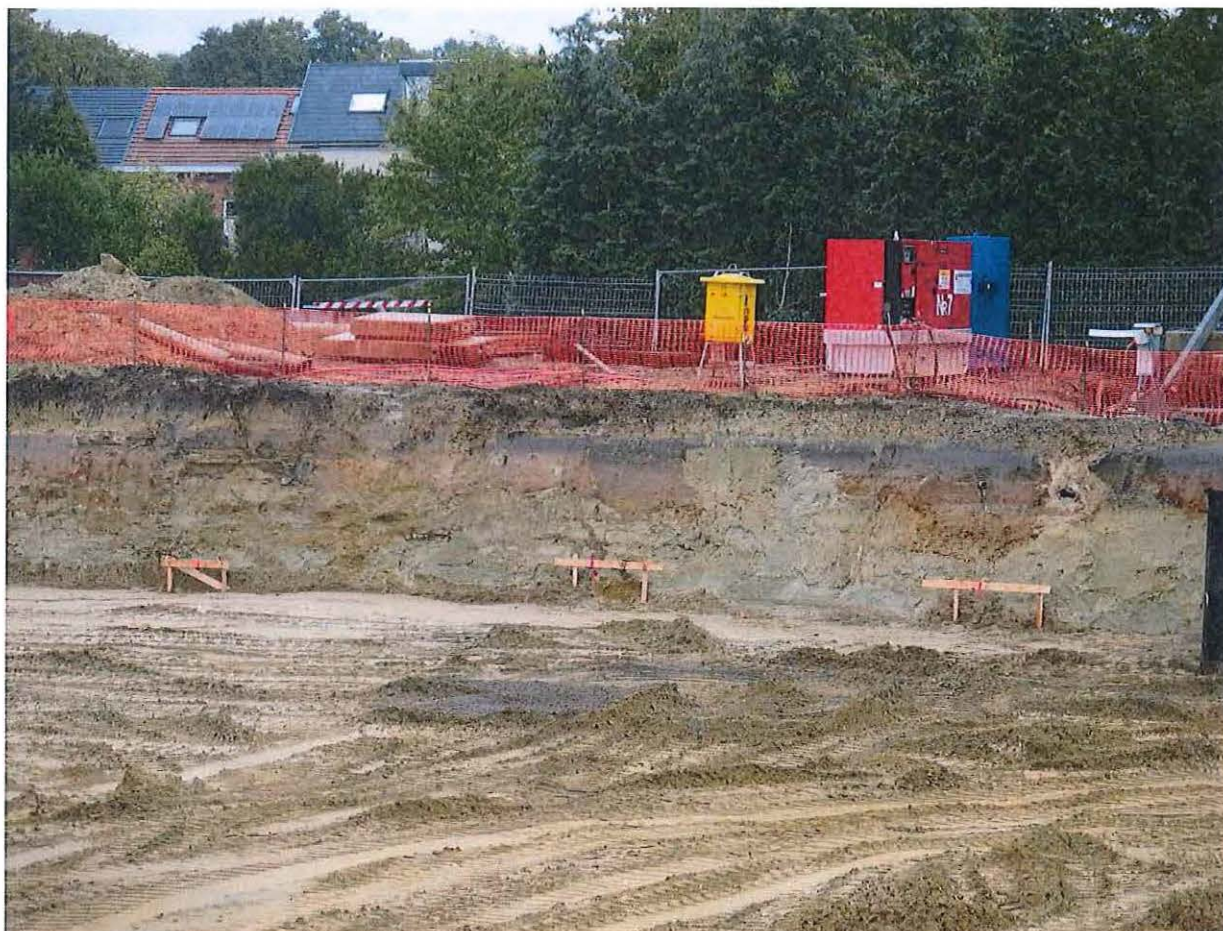
Zicht op bouwput in bleekgroengrijs Zand van Brussel, met bovenaan aangebrachte grond op verstoord bodemprofiel, met leidingen waarvan de uitgraving hetzij met leem hetzij met brusseliaans zand werd opgevuld (foto 8.10.2015).
