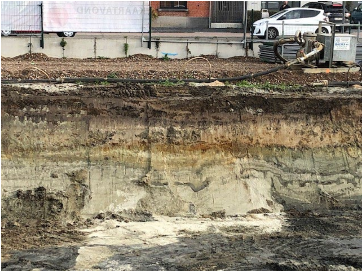
Overzicht noordelijke bouwputwand.
