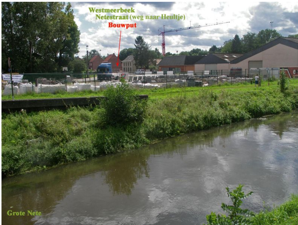
Lokalisatie bouwput Netestraat, voor bouw sociale woningen (foto J. Barbier)
