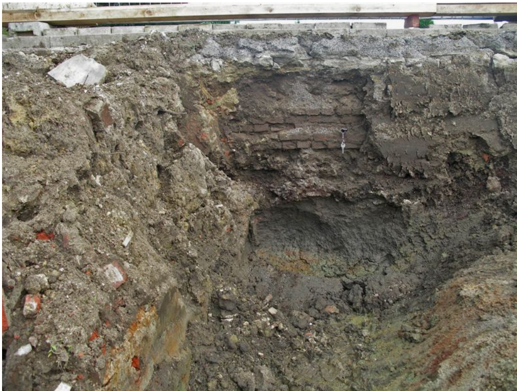
bouwput met baksteen funderingslagen onder opgehoogde grond, boven op ijzeroerbank, gevolgd door vochtig grijs venig zand en groen zand op de bodem ba, de bouwput (foto J. Barbier)
