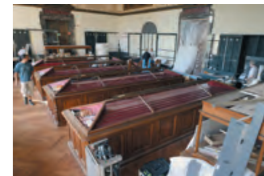
Arbeiten im Saal 5
